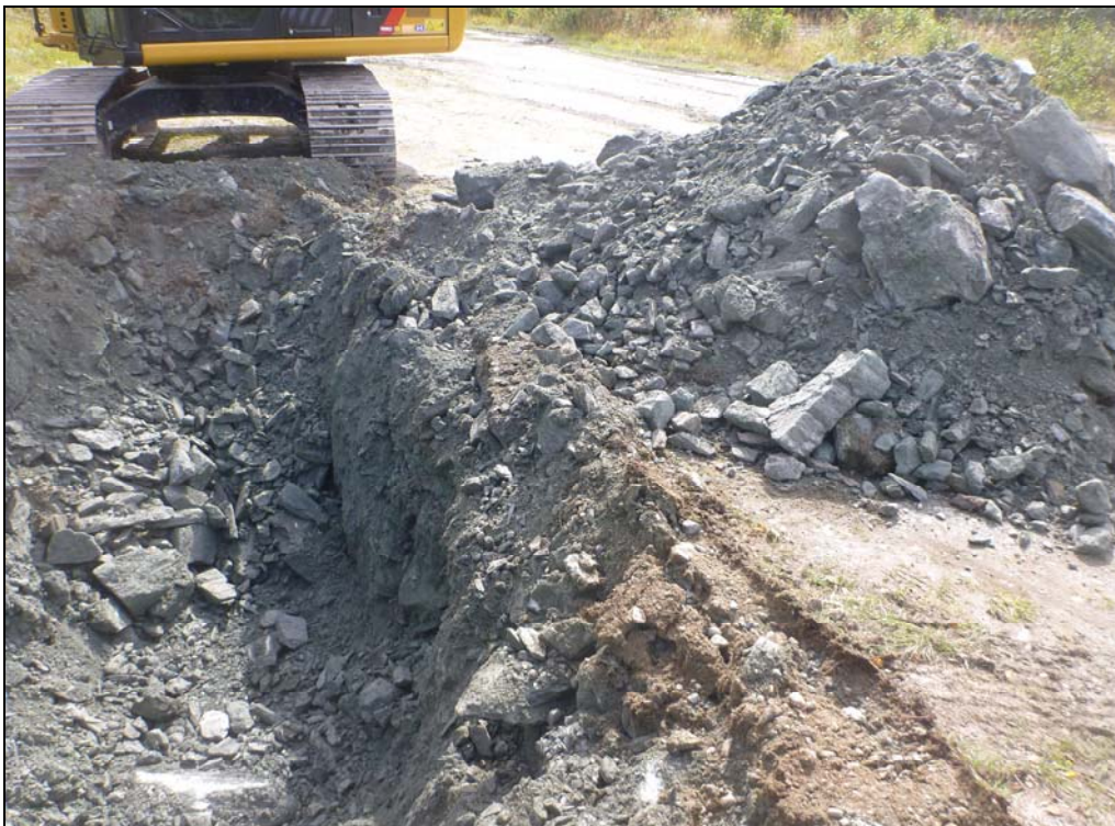
Figur 5 Sjakt i punkt 11: grov sprengstein over stedlig grunn. Merk at det ikke er samme rustutfelling som i masser lenger syd.
