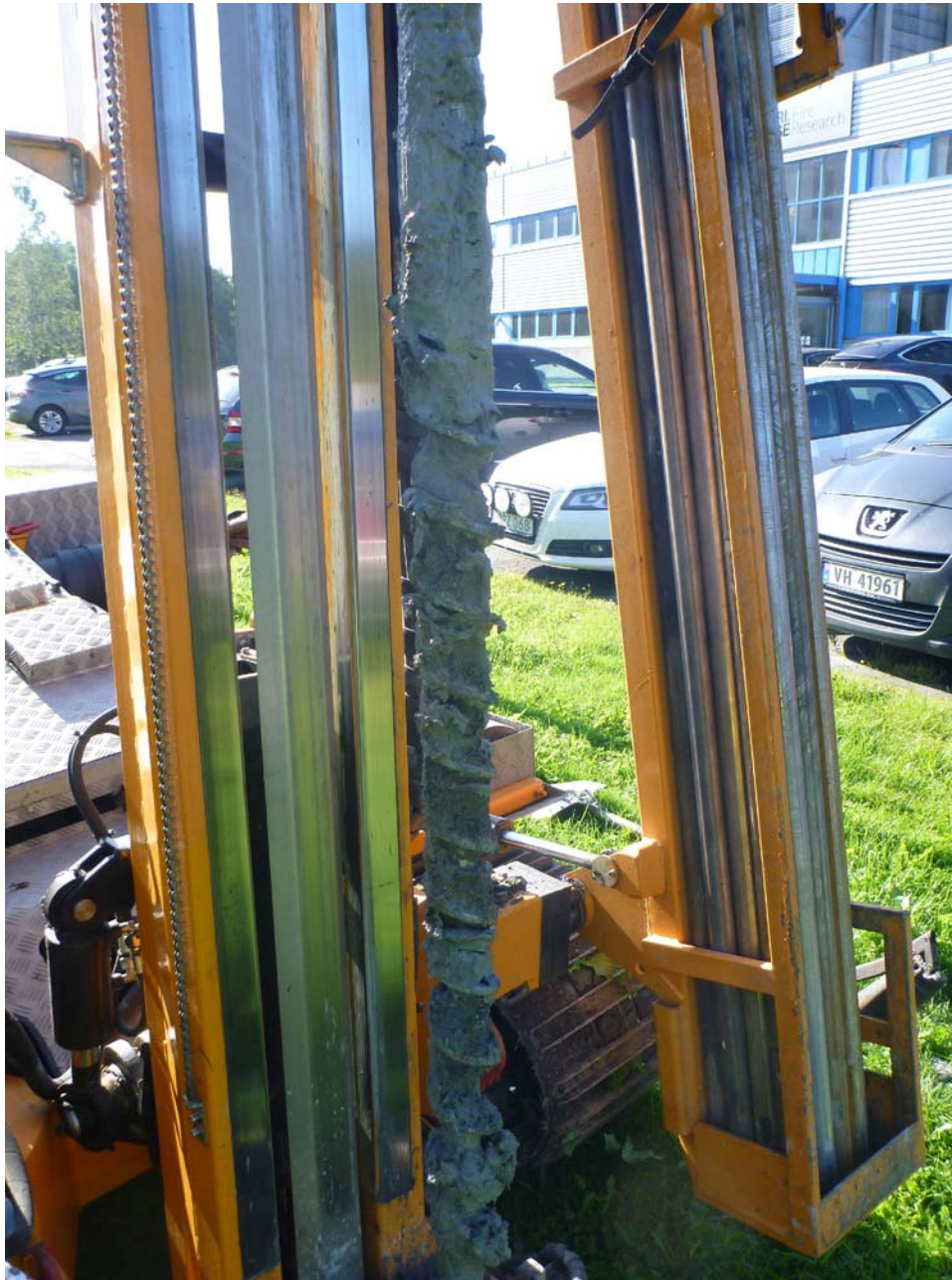
Figur 9 Masser fra 4 – 5 m under terreng i punkt 22, som er planlagt dybde for fjernstyrt boring i dette punktet.
