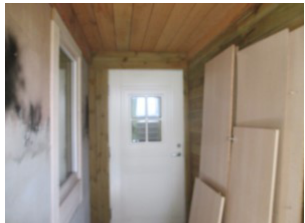
Bilde 3.11 Impregnert panel vegg
