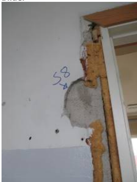
Bilde 3.20 Murpuss vegg skolebygg
