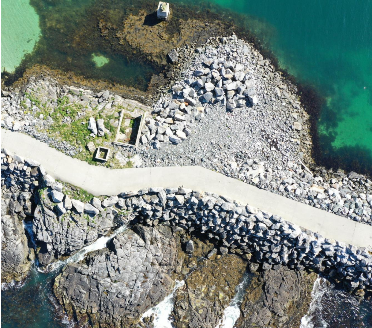
Bilde 3: Skarvbarden molo – landing. (Bilde: Kystverket Nordland).
