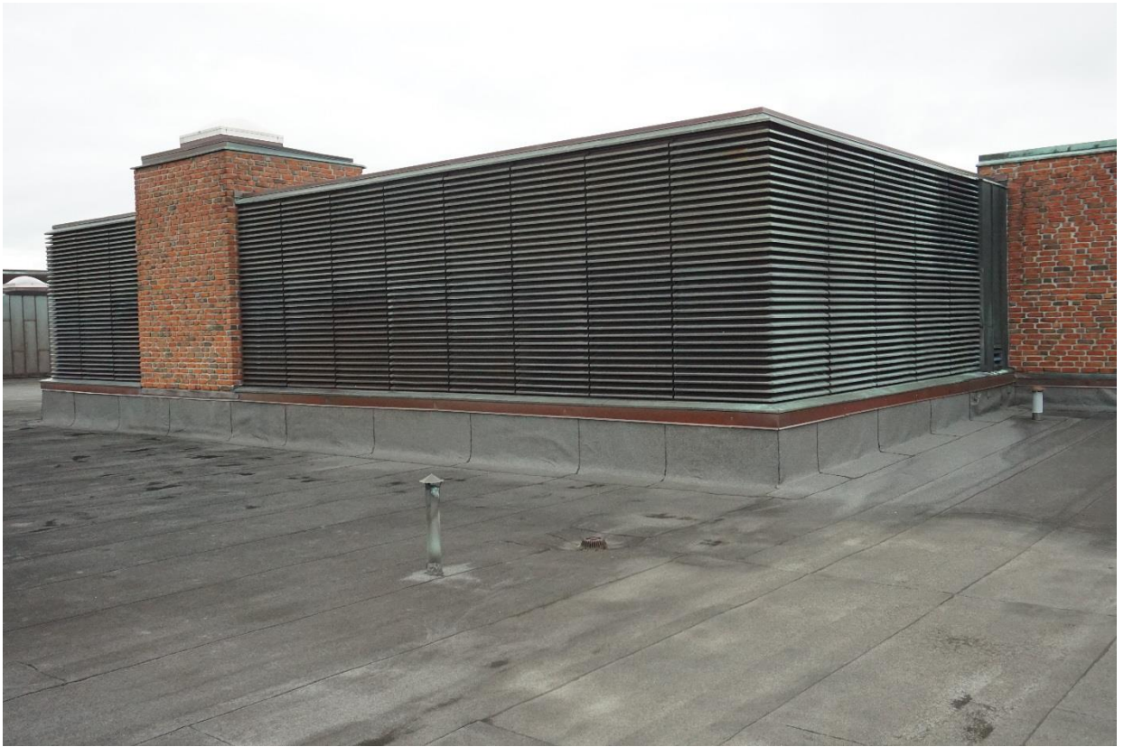
C fløy høy, ventilasjons-hus tak
