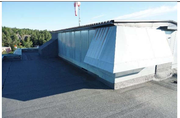
Tak D fløy «vestfasade» aggregathus
