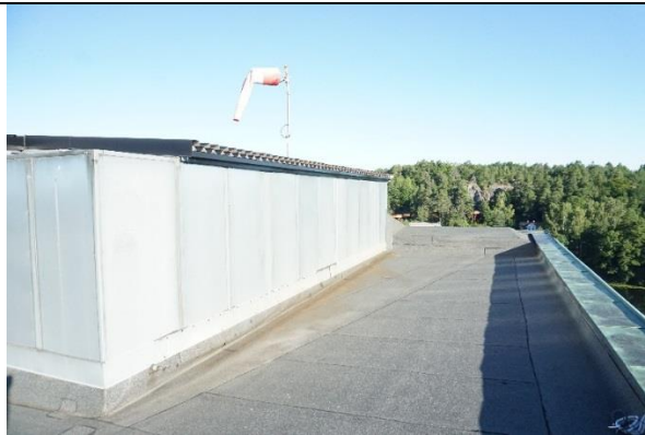
Tak D fløy «østfasade» aggregathus
