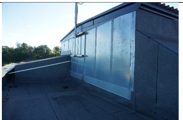
Tak D fløy «vestfasade» aggregathus
