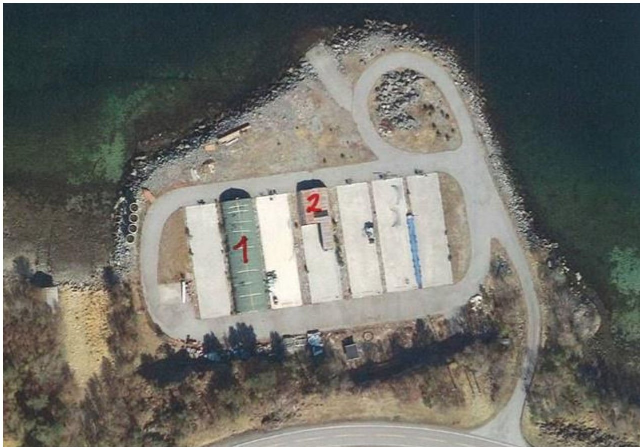
Figur 1 - Oversiktsbilde over bygningene.
