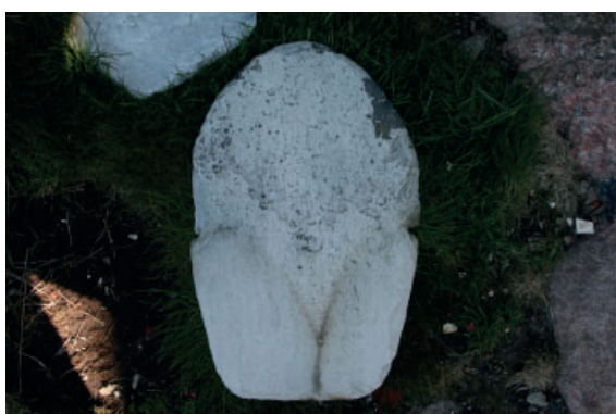
Bilde 10. Bilde av eksisterende takstein. Det finnes en del takstein som er lagret i kjelleren i hovedboligen.
