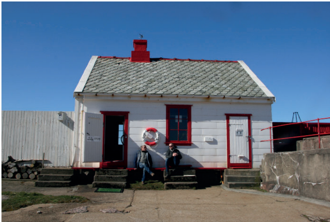
Bilde 1. Noe skifer takstein har blitt blåst av. Bilde fasade mot nordøst.
