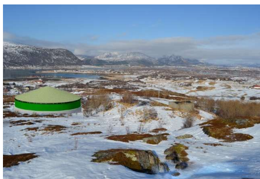
Prefabrikkert basseng av GUP (fotomontasje)
