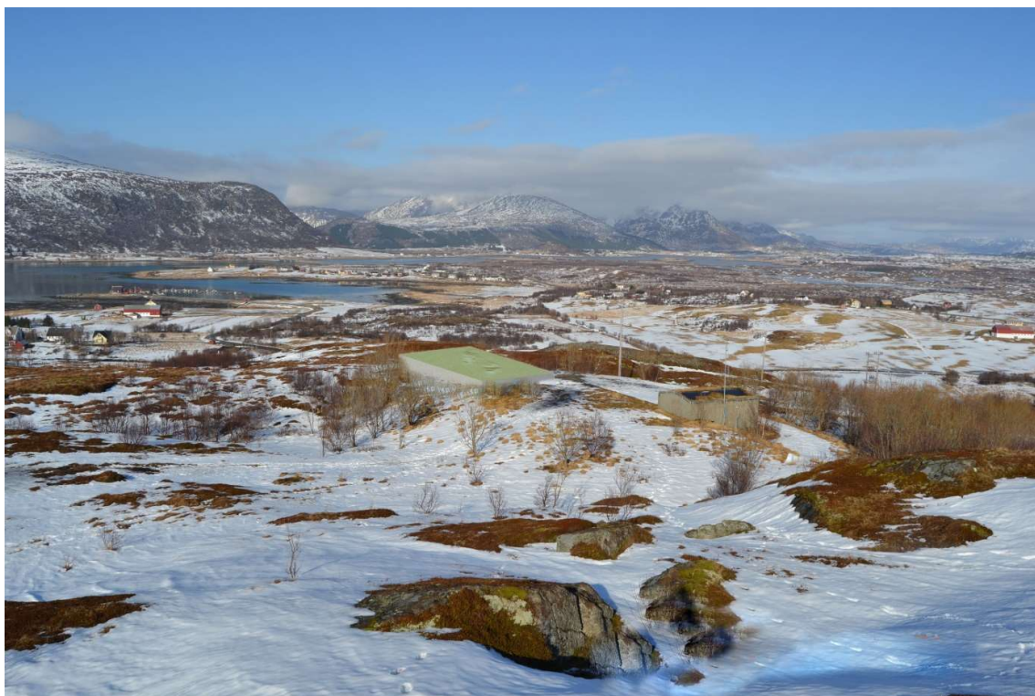
Bilde 2: Plasstøpt basseng ved siden av det eksisterende.
