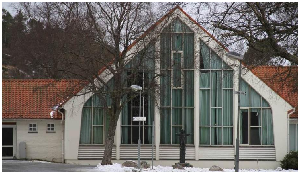
Fig 14 Eksempel på tidstypiske arkitektoniske kvaliteter ved tidligere Vestlandsheimen (Kilde: Bergen kommune, Byantikvaren 2013).
