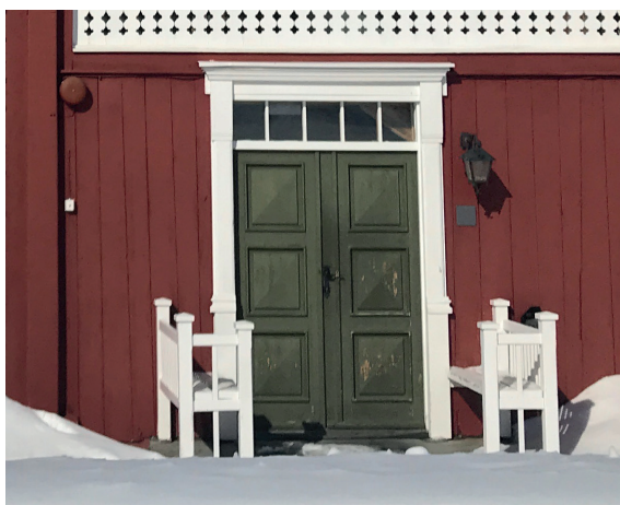
Dagens inngangsdør. Tofløyet med overlys. Malt.
