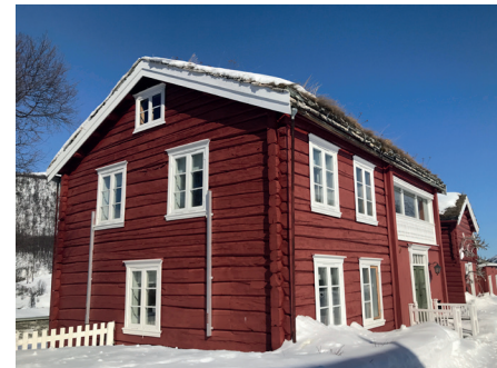
Sør og østfasade, Nordre. Veggmonterte brannstiger mot sør.
