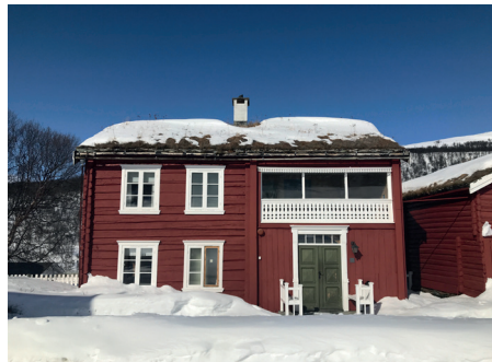
Østfasade med hovedinngang. Innglasset svalgang i 2. etg.
