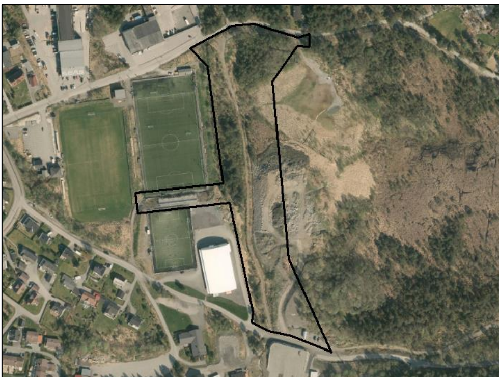
Figur 6 Flyfoto som viser dagens situasjon. Hensynssonen er vist med sort strek.
