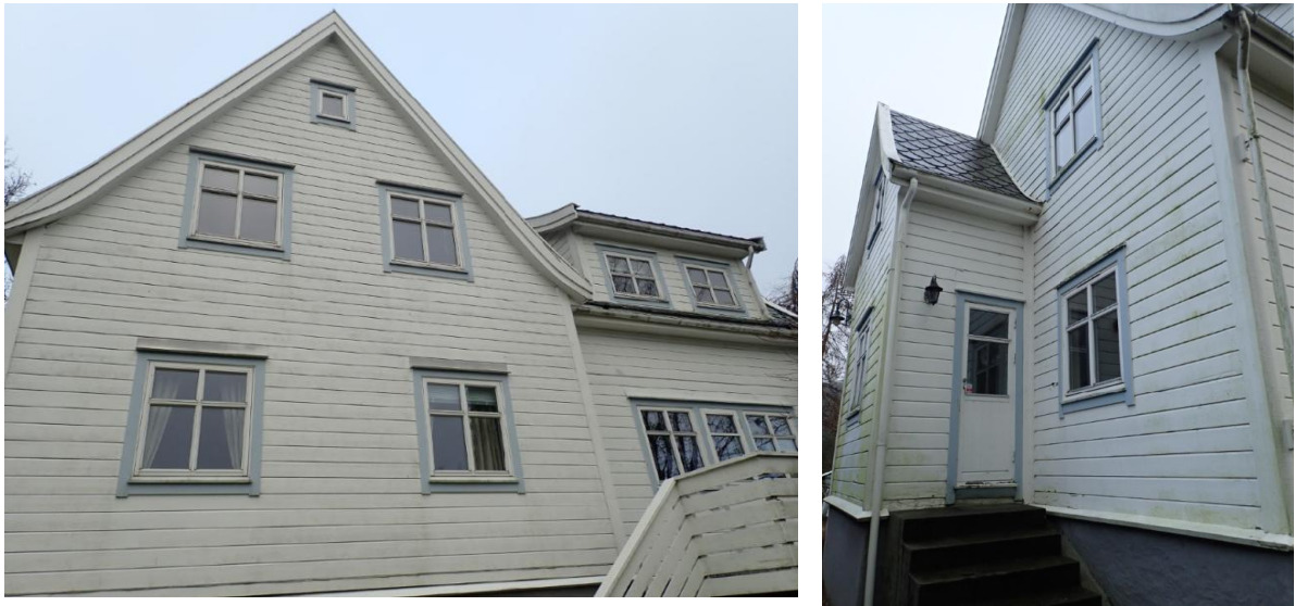
Figur 3: Fasadebilder av bolighuset. Bilde t.v. er vendt mot sør, med tilbygg fra 80-tallet til høyre. Bilde t.h. viser del av nordfasade, med påbygget inngangsparti fra 60-tallet.
