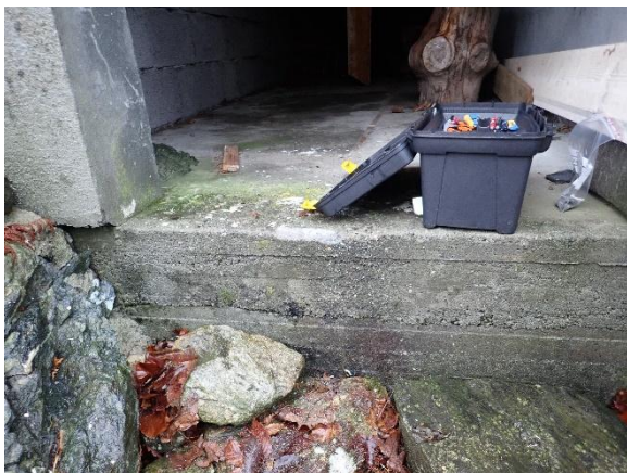
Bilde B13: P09 – Betonggulv under terrasse, tilbygg.
