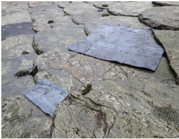
Bilde B35: Åpninger mellom skiferstein tettet med blybeslag.
