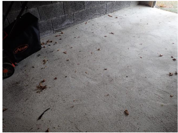
Bilde B10: P06 – Betonggulv garasje
