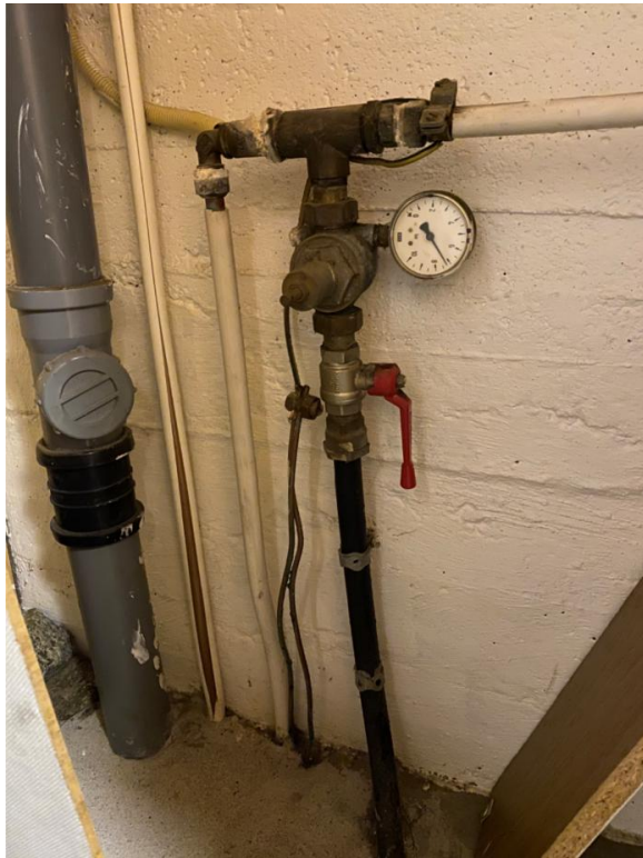
Bilde B25: Trykkmåler/ventil i kjeller.
