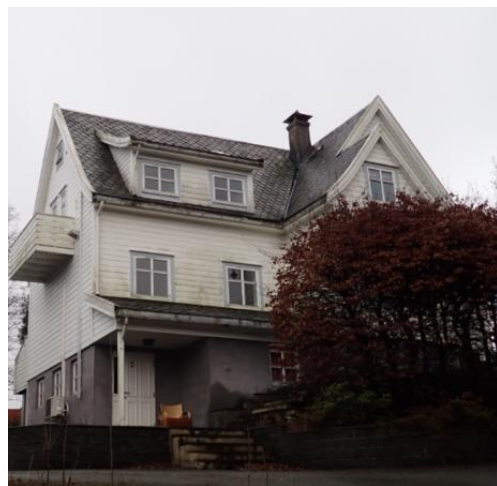
Bilde B42: Fasade sett fra oppkjørsel.
