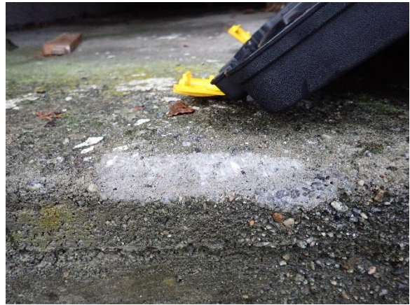
Bilde B12: P09 – Betonggulv under terrasse, tilbygg.
