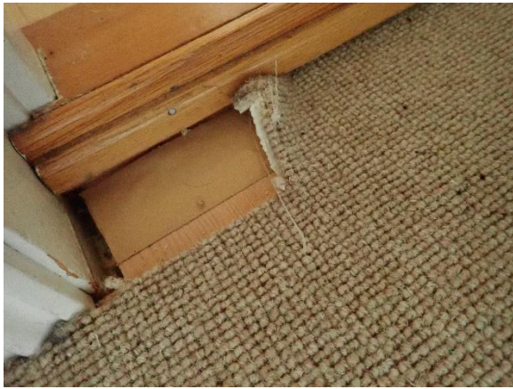
Bilde B9: P05 – Gulvteppe, gang ved trapp 2.etg.
