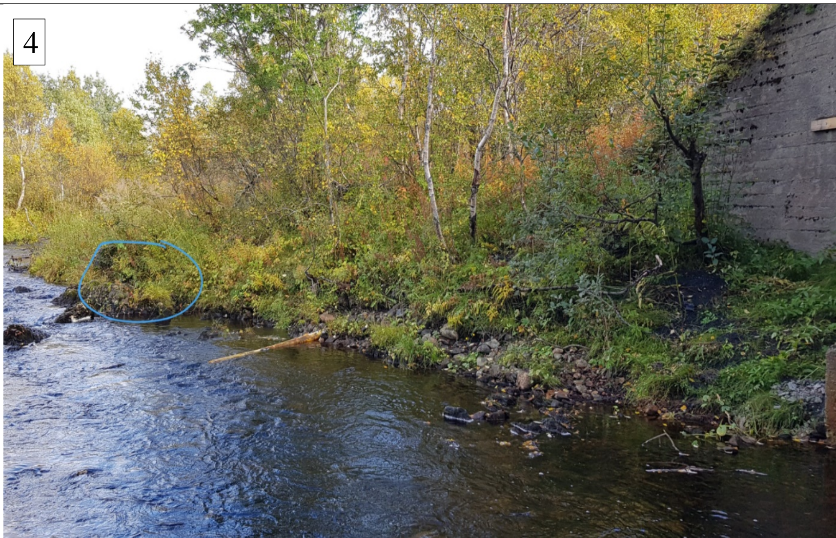
Figur 11: Observert berg innringet på oppstrøms side av brua over fv. 820. Vingemuren til brua ses i bildets høyere side.
