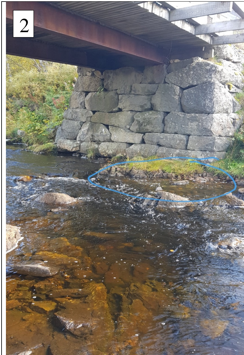
Figur 9: Observert berg innringet under fundamenten til den gamle brua.
