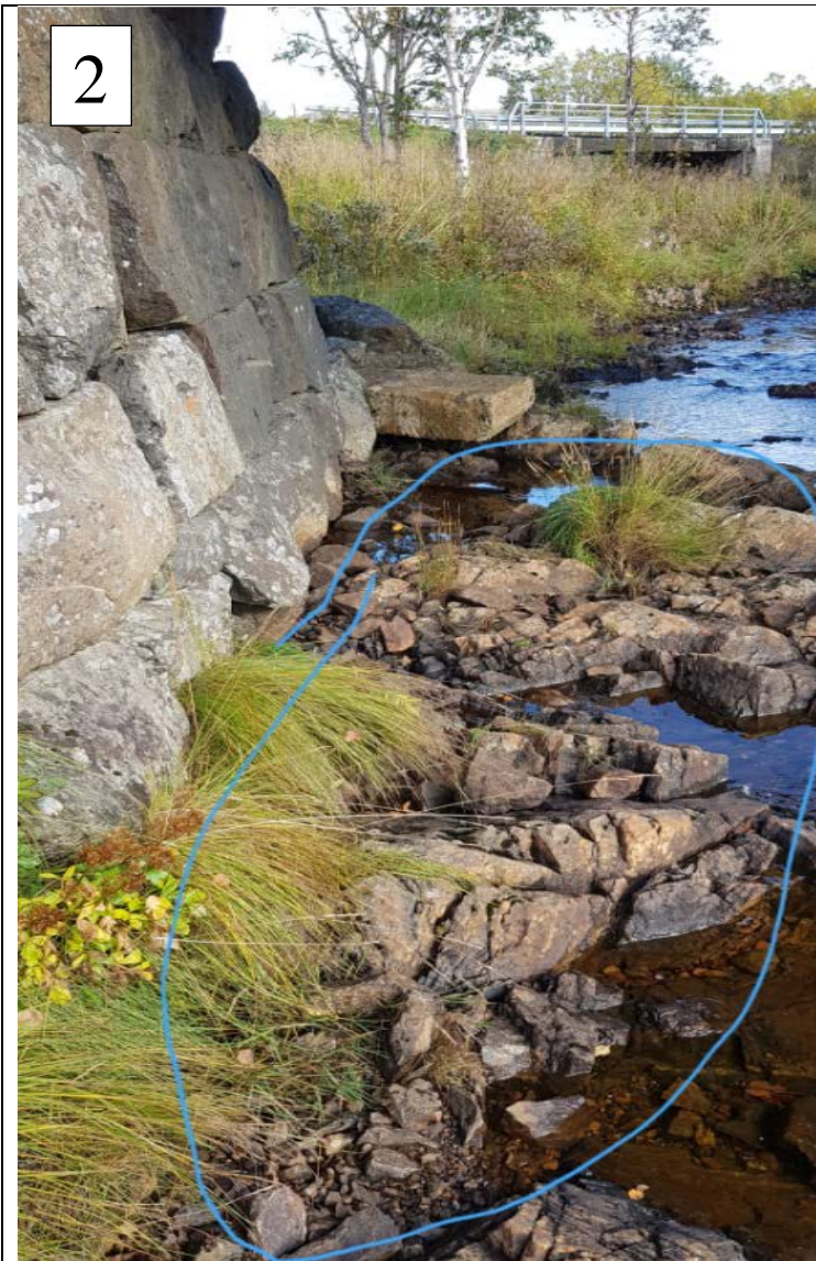
Figur 8: Observert berg innringet under fundamenten til den gamle brua.
