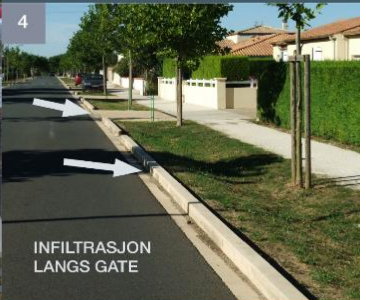
FIGUR 4 Trinn 1: Infiltrasjonsløsninger (tørre løsninger) egnet for vei- og gatevann. 1 Infiltrasjonssone m/underliggende kombinert drener-/overløpsledning langs boliggate med opphevede sluk for overløp/flomsikring 2 Infiltrasjonssone ettermontert på eksisterende P-plass i Reykjavik 3 Infiltrasjonsbasseng for veivann på Fornebu beliggende i parkområde 4 Infiltrasjon i nedsenket grøntrabatt, avrenning via spalter i kantstein. En 2,5 m bred og 25 cm nedsenket rabatt kan magasinere et regn på ca. 45 mm på overflaten (avrenning fra bredde gate + fortau = 7 m). (Foto: 1. Green Lundberg, 2. Tori Island, 3. 4. GWW)
