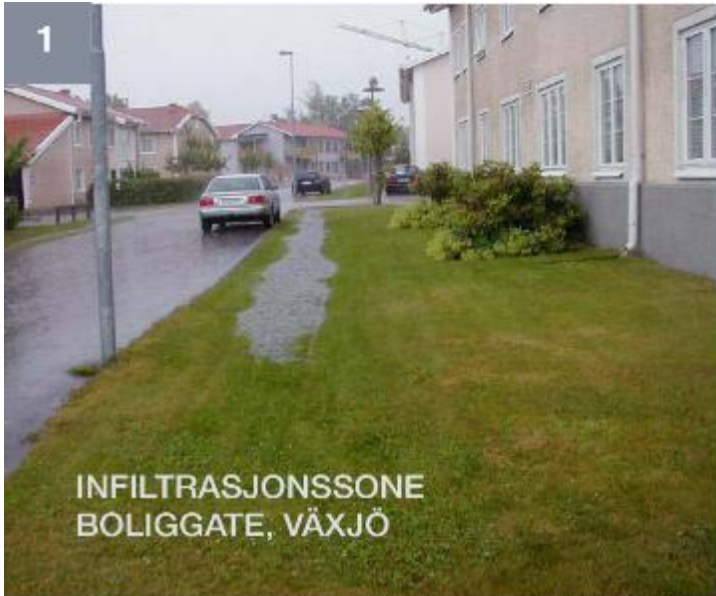
FIGUR 4 Trinn 1: Infiltrasjonsløsninger (tørre løsninger) egnet for vei- og gatevann. 1 Infiltrasjonssone m/underliggende kombinert drener-/overløpsledning langs boliggate med opphevede sluk for overløp/flomsikring 2 Infiltrasjonssone ettermontert på eksisterende P-plass i Reykjavik 3 Infiltrasjonsbasseng for veivann på Fornebu beliggende i parkområde 4 Infiltrasjon i nedsenket grøntrabatt, avrenning via spalter i kantstein. En 2,5 m bred og 25 cm nedsenket rabatt kan magasinere et regn på ca. 45 mm på overflaten (avrenning fra bredde gate + fortau = 7 m). (Foto: 1. Green Lundberg, 2. Tori Island, 3. 4. GWW)
