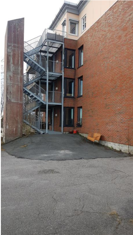
Figur 15 Område hvor tilbygg sør skal etableres
