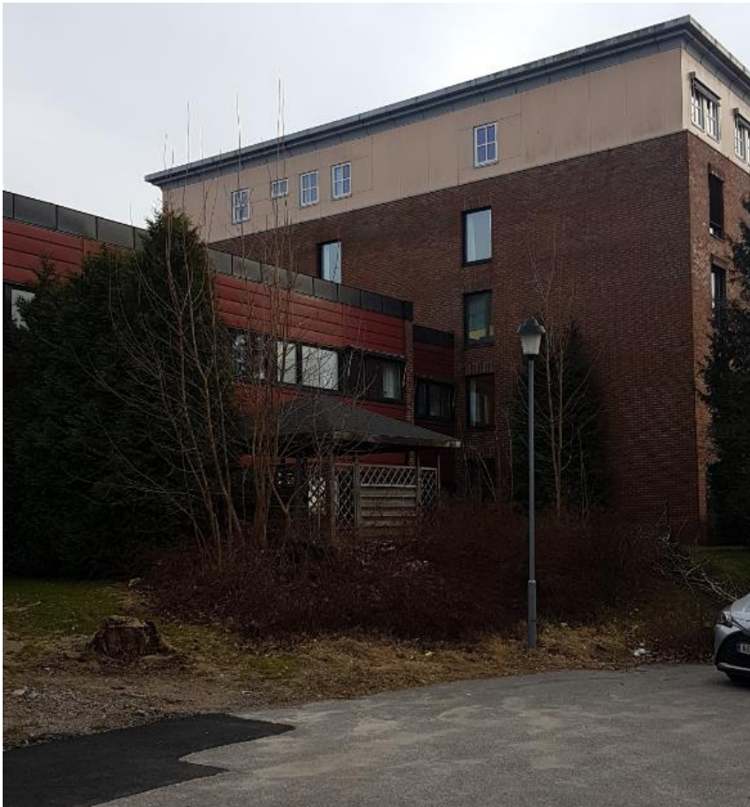
Figur 16 Område for etablering av tilbygg vest, i sammenføyningen mellom helsehuset og mellombygget
