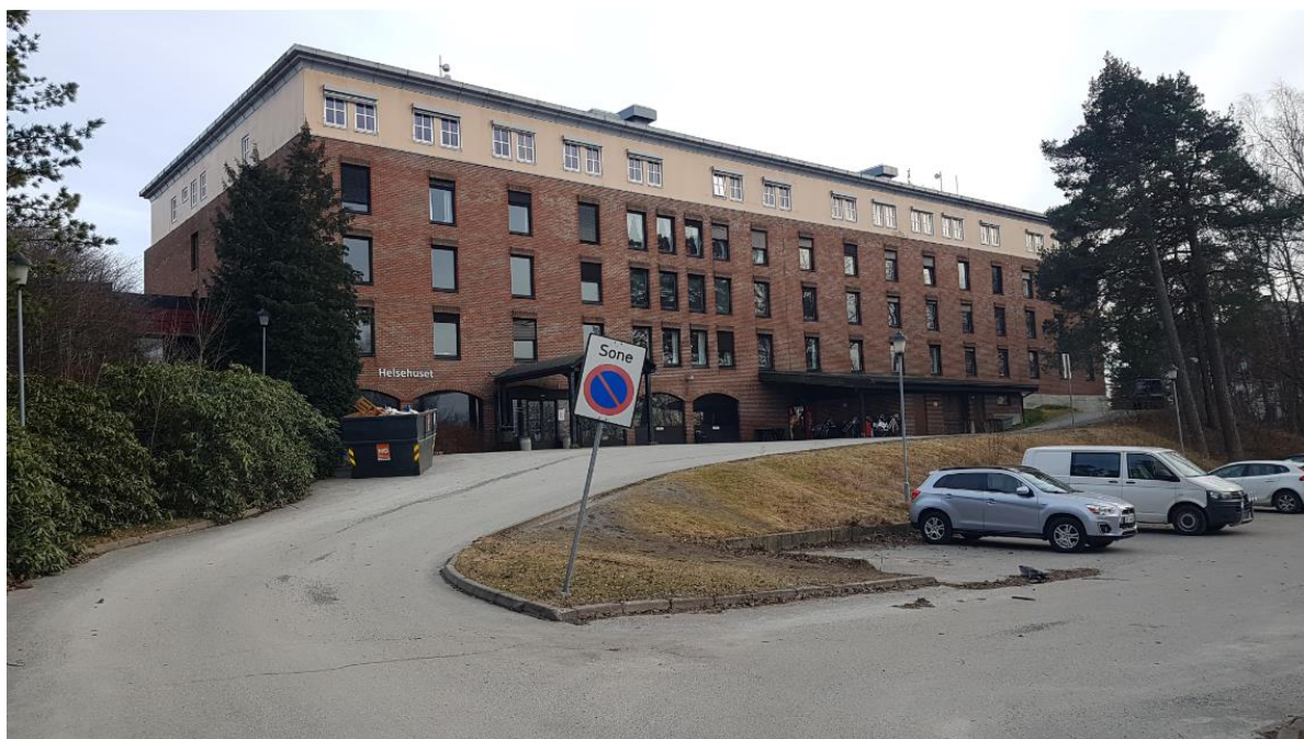
Figur 2: Helsehuset med dagens parkeringsareal til høyre i bildet. Her skal det etableres et parkeringshus over 2 plan
