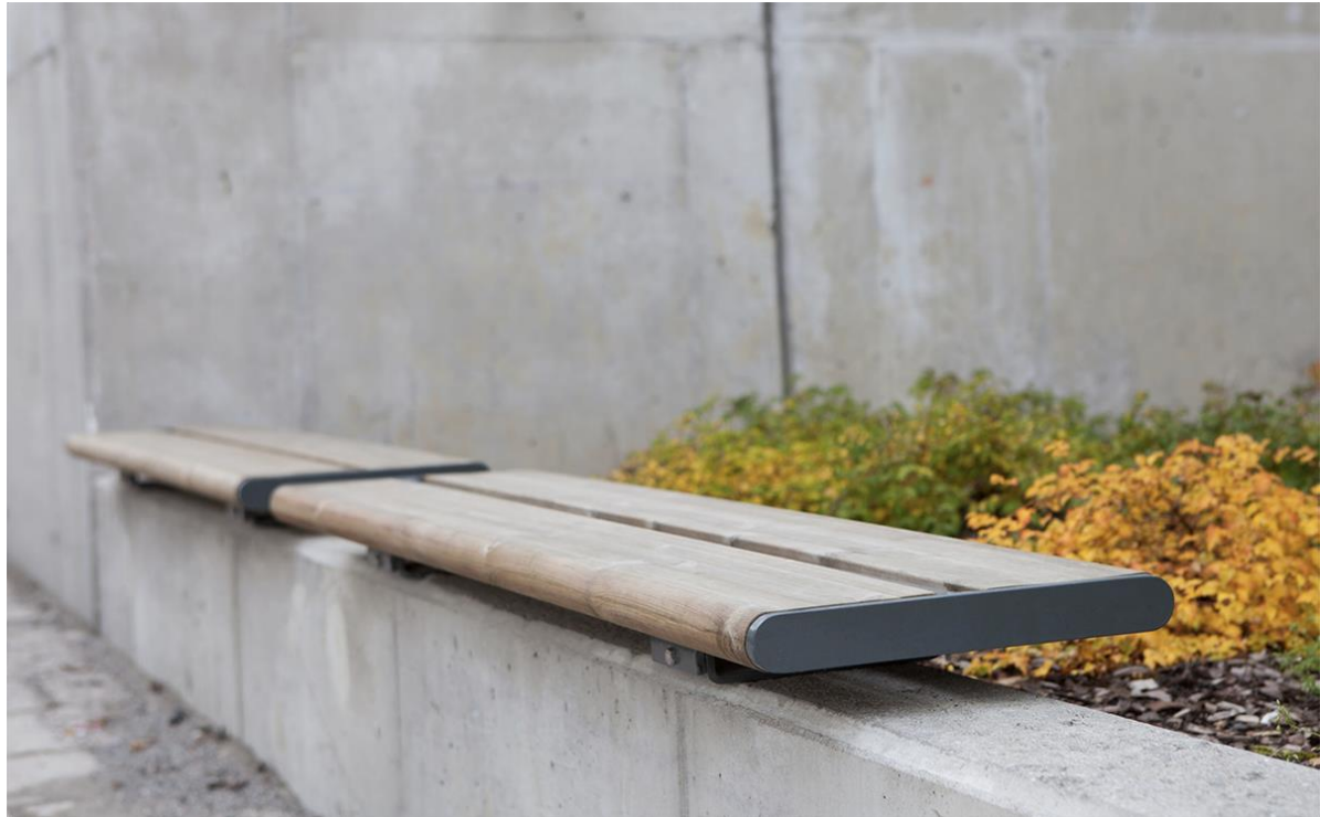
Figur 26: Prinsipløsning for benker på granittmur
