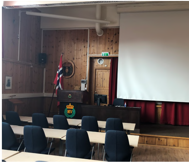
Unødvendig hindringer ved rømningsvei må fjernes.
