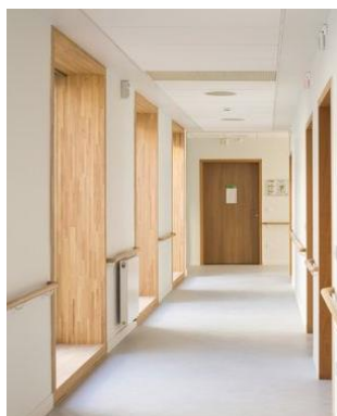
Figur 12 Ref. bilde, dører til beboerrom i laminat med treoverflate
