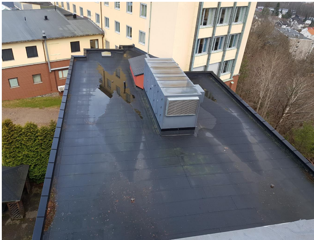
Figur 18 Eksisterende yttertak på mellombygget. Ventilasjonsaggregatet rives.
