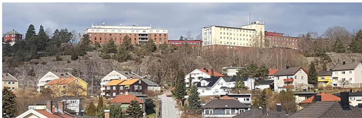
Figur 3: Helsehuset, mellombygget og SØ Halden klinikken på Stangeberget, sett fra Rødsberget
