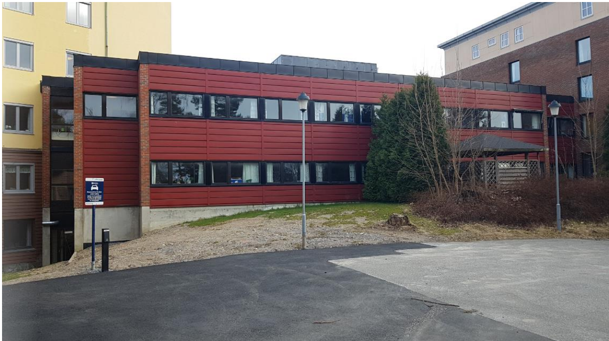
Figur 4: Mellombygget som binder SØ Haldenklinikken sammen med Helsehuset
