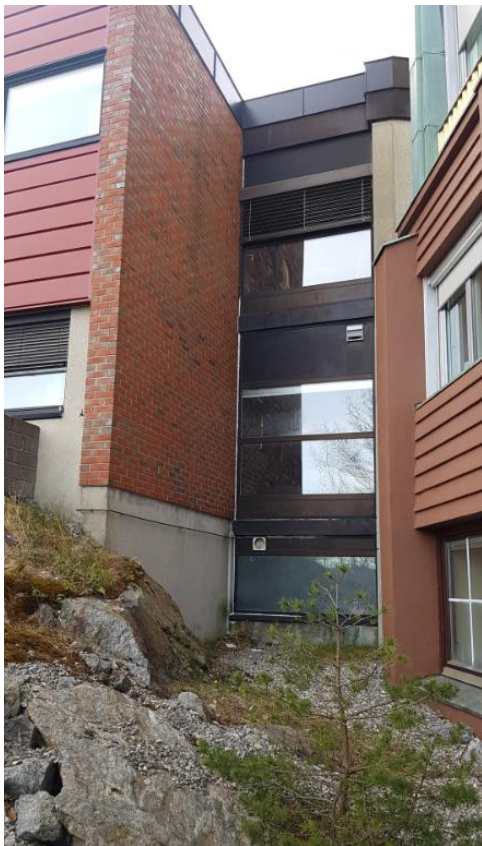
Figur 16 Betongvegger med utenpåliggende teglsten i gavlvegger mot SØ Haldenklubben
