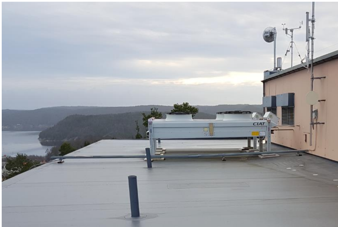
Figur 22 Eksisterende kjøling på tak over 5. etg.
