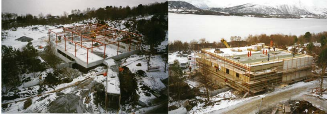
Fig. 3 – Bilder frå eksisterande helikopterbase under bygging
