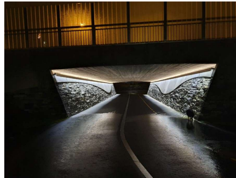
Figur 4 Eksempel; belysningen inne i tunnelen er fin, men kontrasten til utsiden er for stor. Dette påvirker opplevelsen av området.
