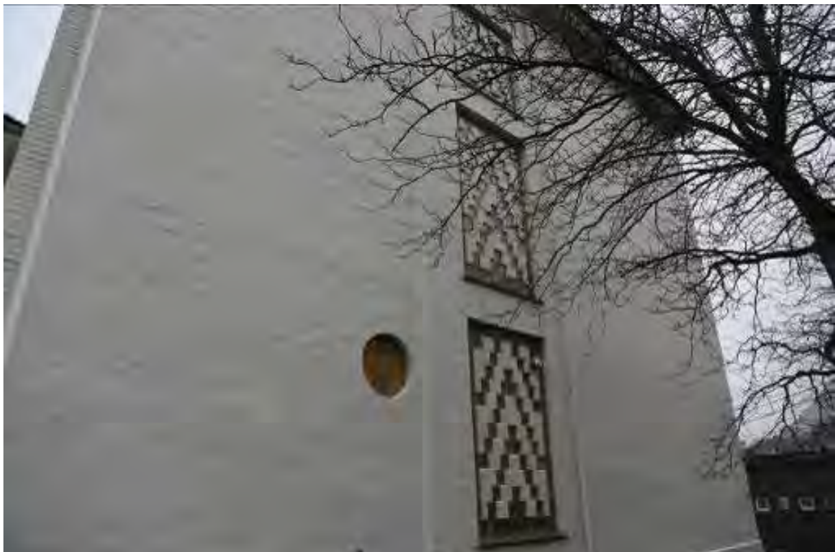
Figur 20 Endeveggen i sør er en stor, tett veggskive der store vinduer i sørenden av korridoren danner et sterkt vertikalt, dekorativt element like ved adkomsten. Vinduene er vakkert utformet med mønster av glassbyggerstein og mur.
