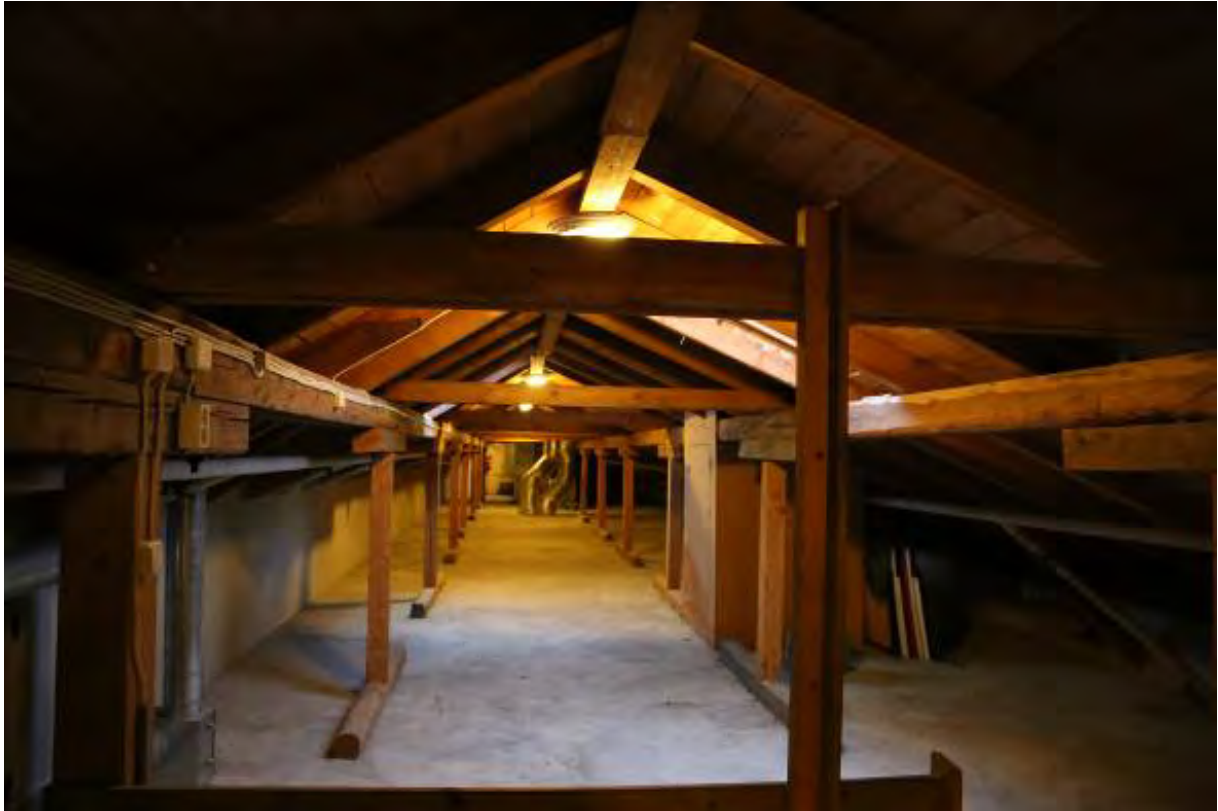
Figur 50 Fra loftet. Sperretakskonstruksjon og sutak.
