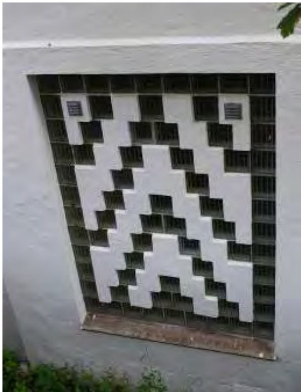
Figur 36 Vindu i glassbyggerstein og mur.
