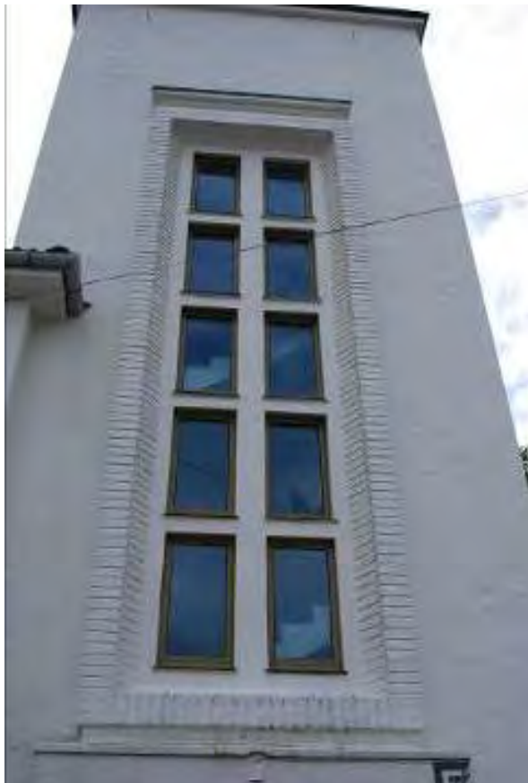
Figur 18 Vinduet i trappetårnet i sør er markert med teglsteinsomramming.
