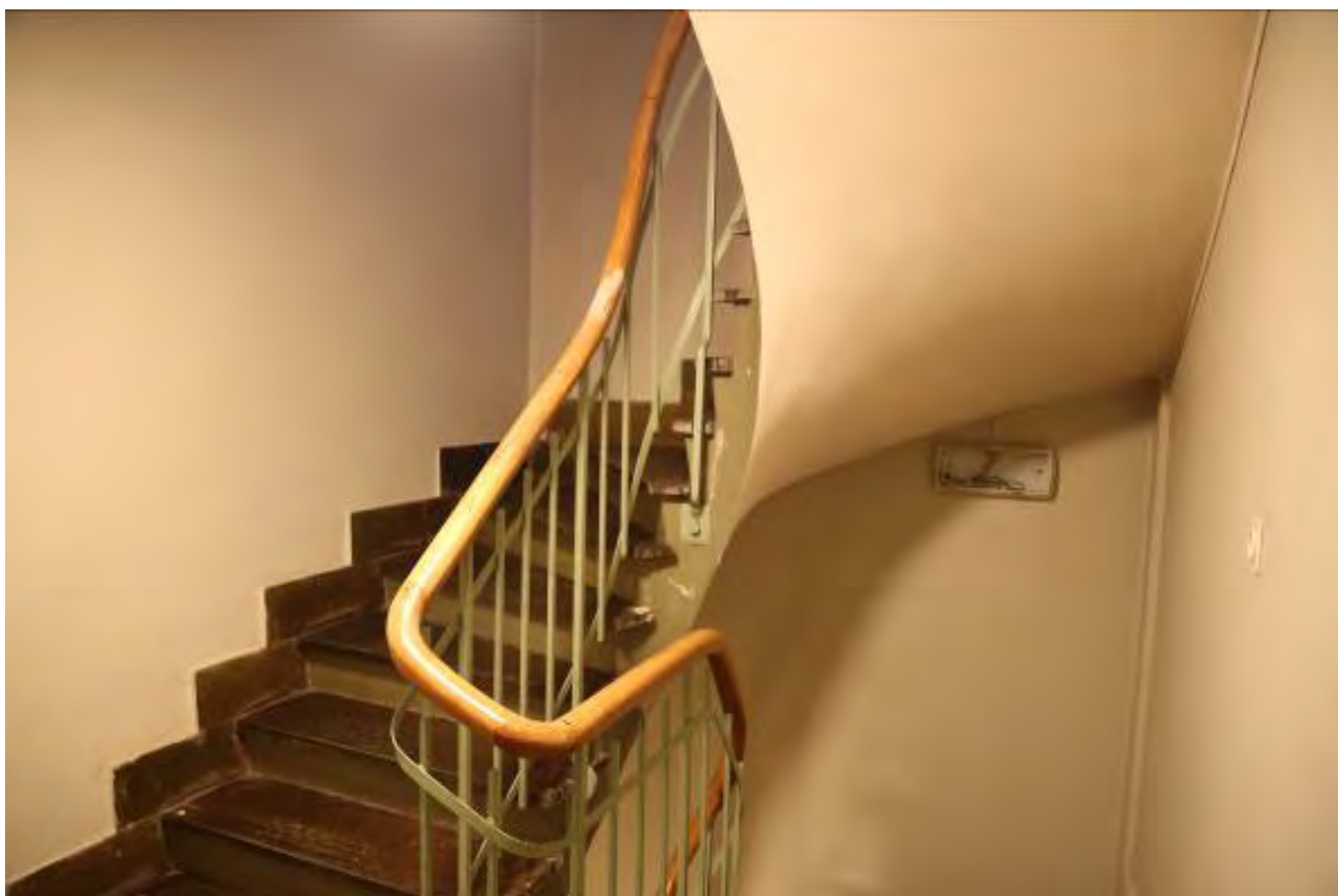
Figur 43 Mens de to hovedtrappene er lagt som fristilte trappetårn, er bitrappen i overgangen til mellombygget/1959-delen integrert i gymsalsfløyen. Også her er materialkvalitetene høye med skifer og edeltre, og trappeløpet har en svungen, skulpturell form.
