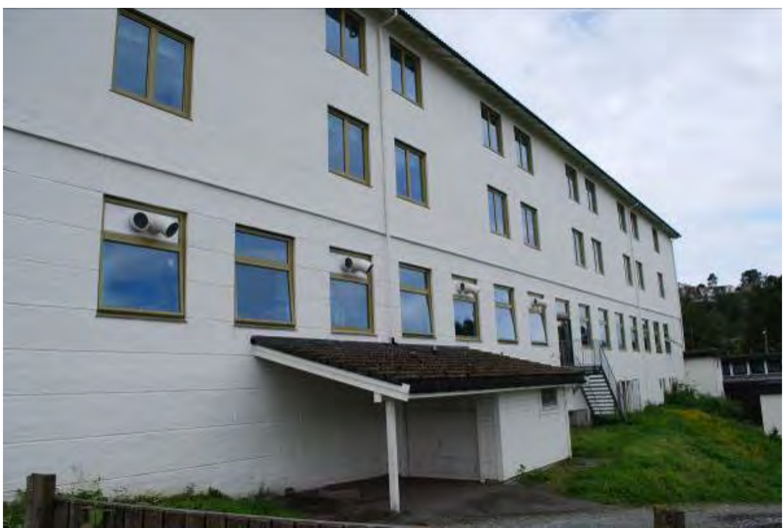
Figur 54 Bygningens bakside mot nordøst er en nøktern fasade.
