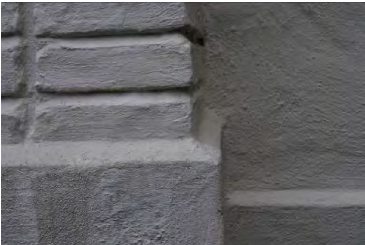
Figur 38 Ulikheter i struktur er en viktig del av fasaden. Sokkeletasjen er markert med et slite sprang ut og er helt glattpusset.
