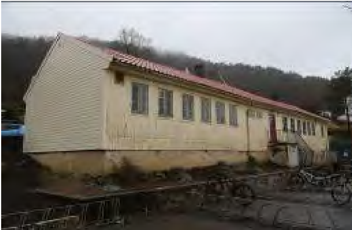
Figur 7 Den langsmale bygningen er fundamentert på murt teglsteinsmur i fallende terreng.
