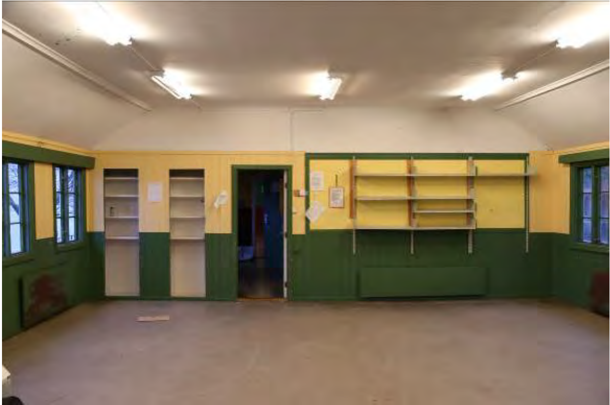
Figur 13 Også innvendig ser mye av det faste inventaret, som skap og veggkledning, også ut til å være originalt. Innerveggene har stående faspanel.
