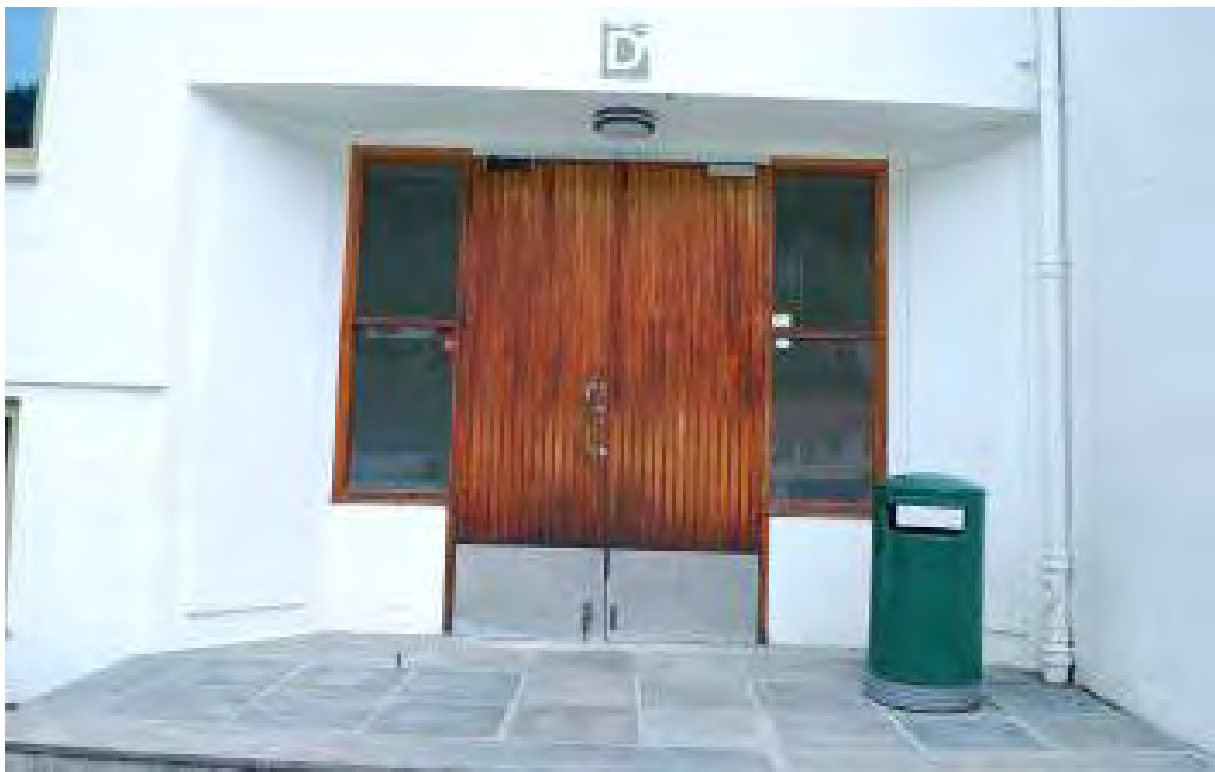
Figur 56 Inngangsdør til høyre/østenden er av eik med sidefelt i glass. Den er tidstypisk utformet.
