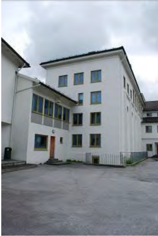
Figur 23 Inn mot mellombygget og 1959-delen er gymsalsfløyen enkelt utformet, med tofagsvindu jevnt fordelt.
