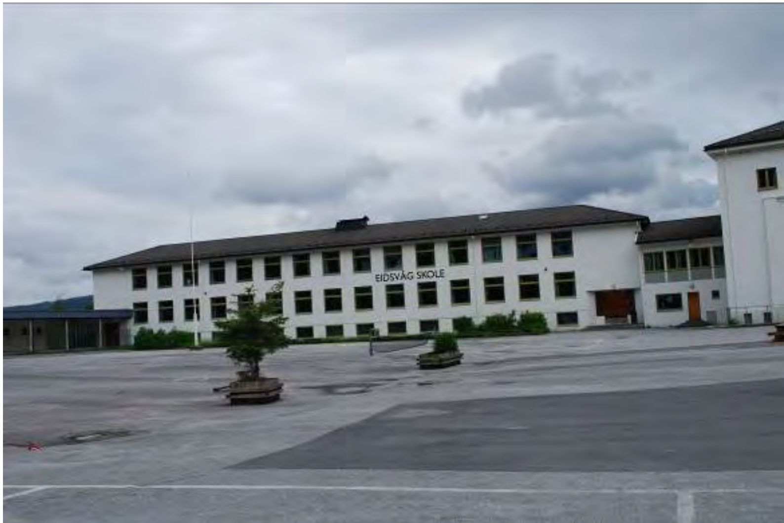
Figur 53 Klasseromsfløyen fra 1959 har en enkel, nøktern form som er tilpasset hovedbygningen. Det er inngangsdører lengst til høyre og venstre på langfasaden mot sør/skoleplass.
