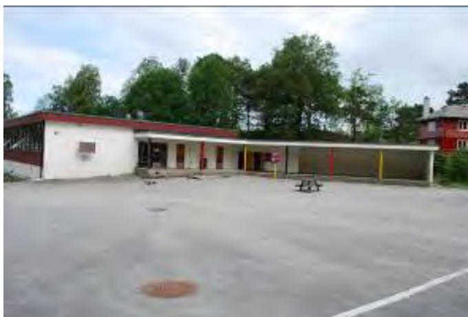
Figur 78 På østsiden går et leskur diagonalt ut fra bygningen
