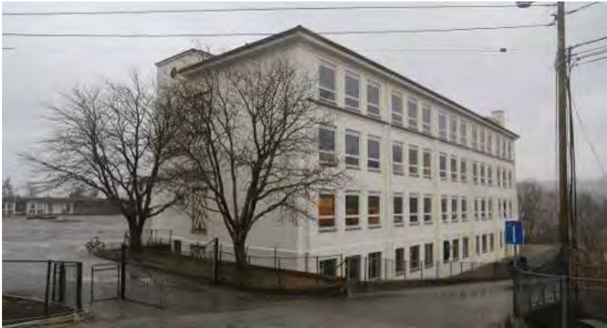
Figur 19 Østfasaden av klasseromsfløyen har en ensartet, repeterende utforming. Her er selve inndelingen av hvert vindu endret i forhold til det opprinnelige, som var stortutete vindu med seks ruter. Støttepilarene har en tydelig estetisk funksjon i tillegg til den konstruktive, og bryter opp det store veggfeltet visuelt. I sørgavlen er det dekorative vindu med glassbyggerstein i hver etasje, som sammen danner en «søyle».
