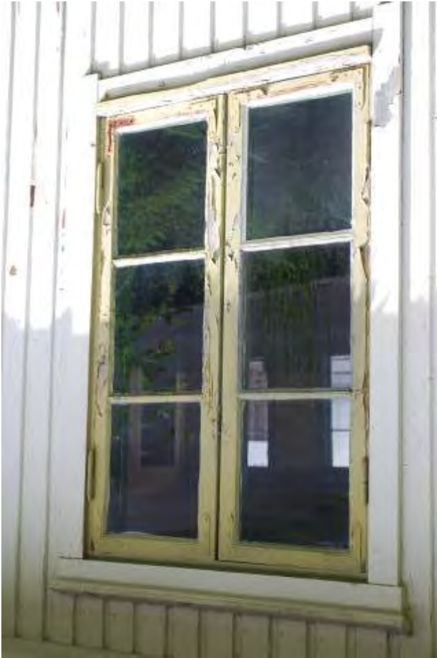
Figur 11 Alle vinduene i langveggene er originale. Det er sidehengslede, tofags vindu med tre ruter i hvert fag. Vinduene har enkelt glass med innervinduer.
