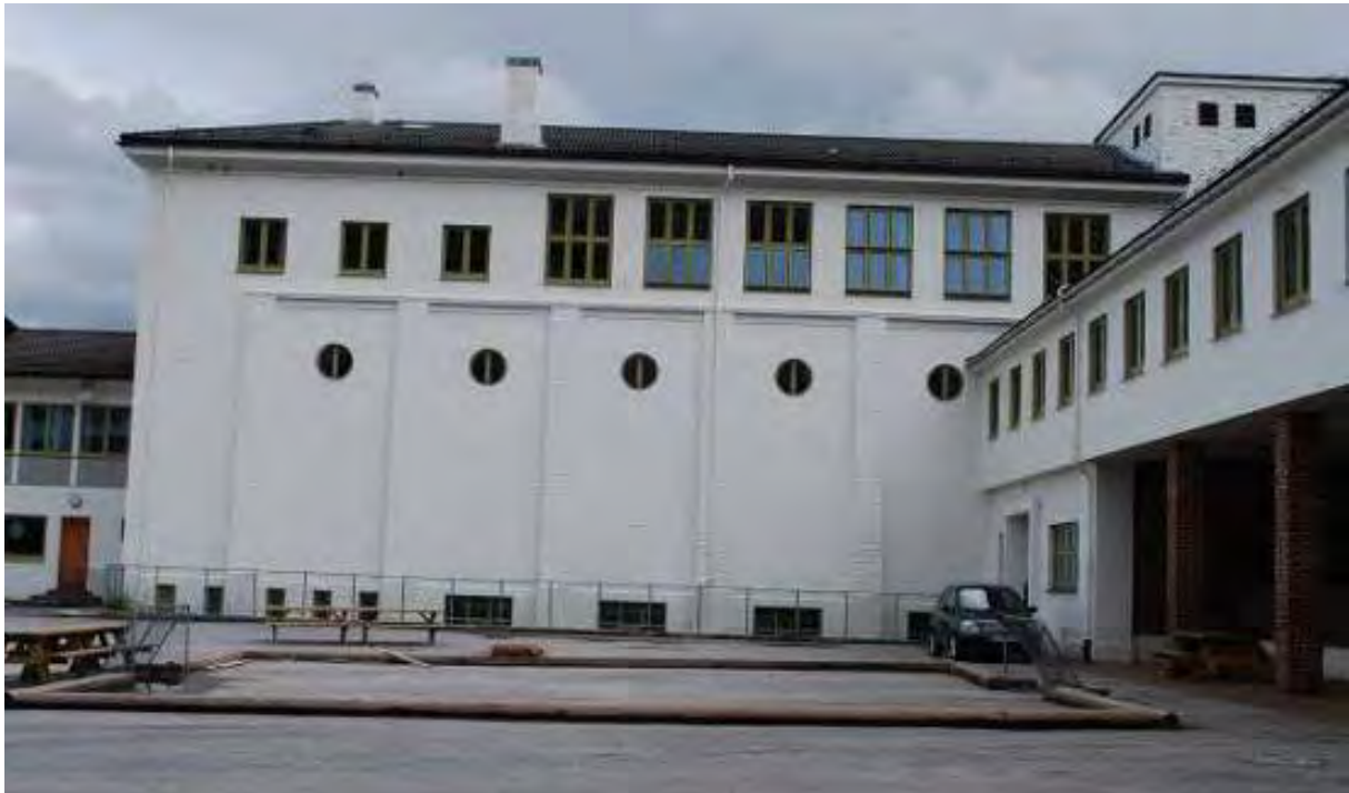
Figur 21 Sørfasaden til gymsalsfløyen har en relativt lukket fasade inn mot skoleplassen. Fasaden er delt opp i fag av fem støttepilarer som bindes sammen med en smal etasjebesims. Øverst i fagene sitter et lite, rundt vindu. Dette er originale vindu. Lysgraven og store vinduer i underetasjen gir den litt tunge fasaden et lettere preg. Det er store vindu også i klasseromsdelen i øverste etasje.
