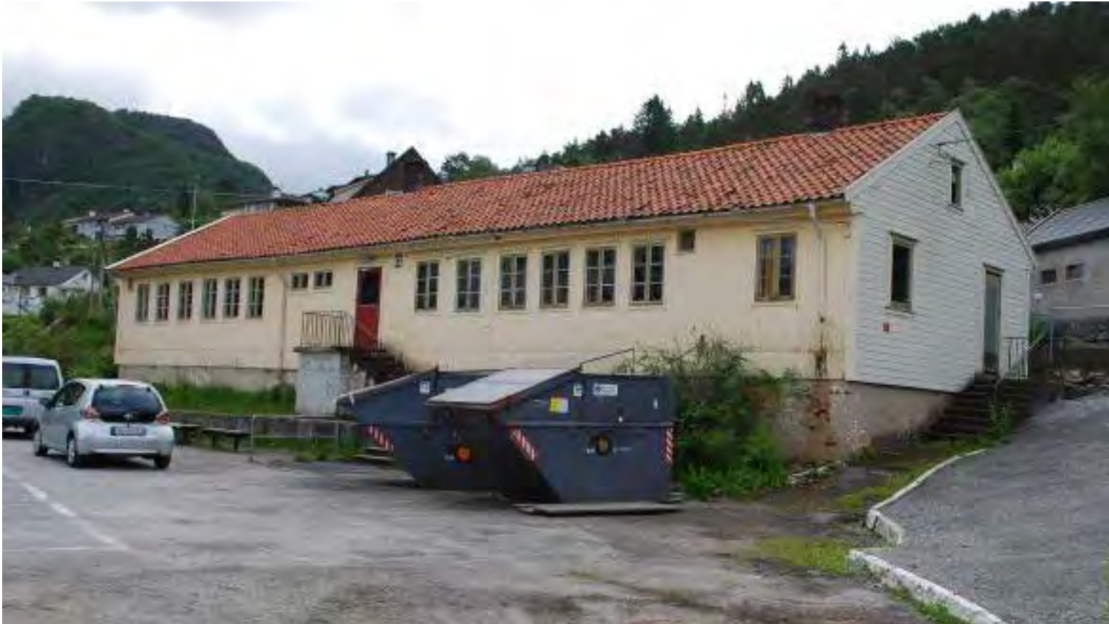
Figur 5 Fasade mot nord har inngang via trapp midt på langsiden. En lemmebrakke består av ulike standardelementer som settes sammen og kombineres med hverandre; takelement, veggelement med vindu, veggelement uten vindu, veggelement med dør etc.
