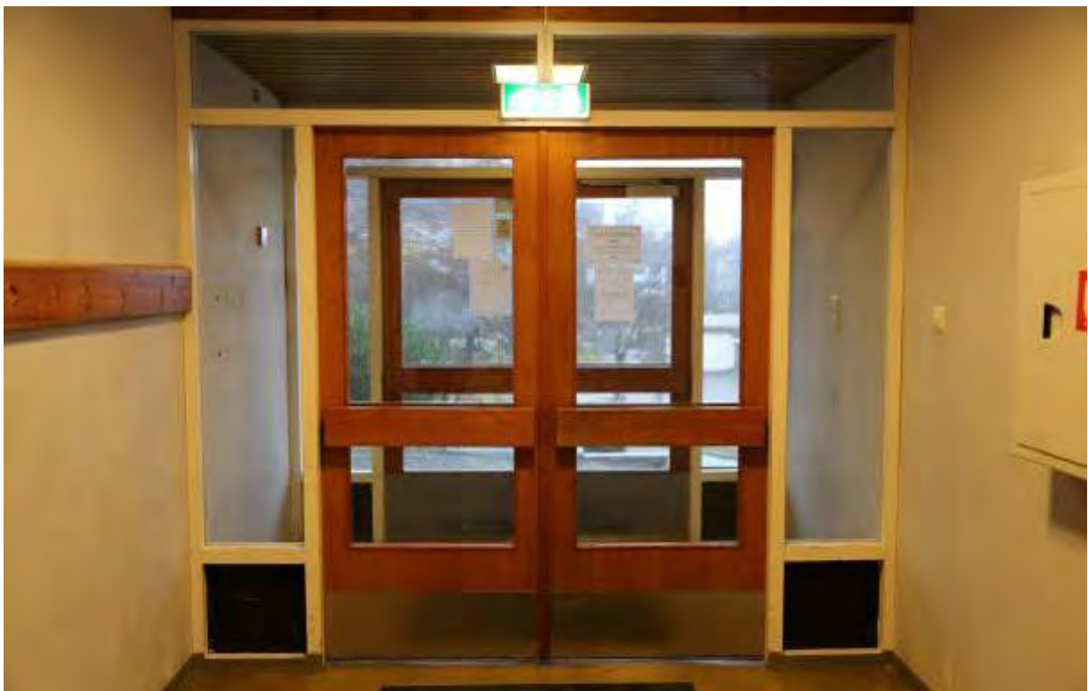
Figur 67 Inngangspartiene er utstyrt med to sett doble teakdører og glass, med vindfang imellom. Den lille brystningen nederst i glassfeltet følger fint opp linjene i dørene.
