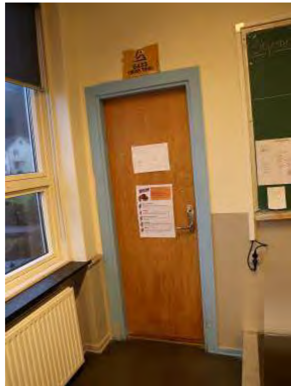
Figur 44 og 45 Originale innerdører av to ulike typer; fyllingsdør med fem speil og en mer moderne, glatt tredør. Særlig fyllingsdørene er det mange av, og de er viktig å ivareta.
