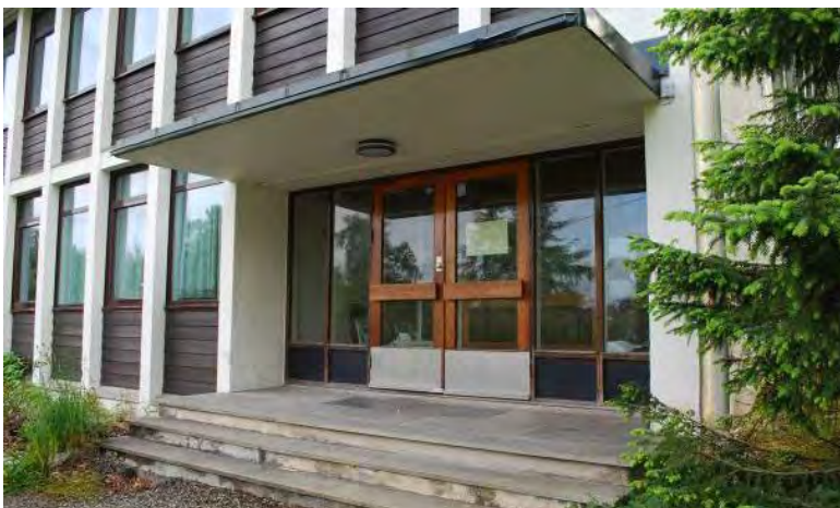
Figur 64 Inngangspartiene i nordvestfasaden har inntrukne dører i teak og glass, med store vindusfelt på siden. Legg merke til den svarte brystningen, som skiller seg fra hovedfasaden. De tynne baldakinene er fasadens eneste utspring, og tilsvarer skifertrappene både i bredde og dybde.
