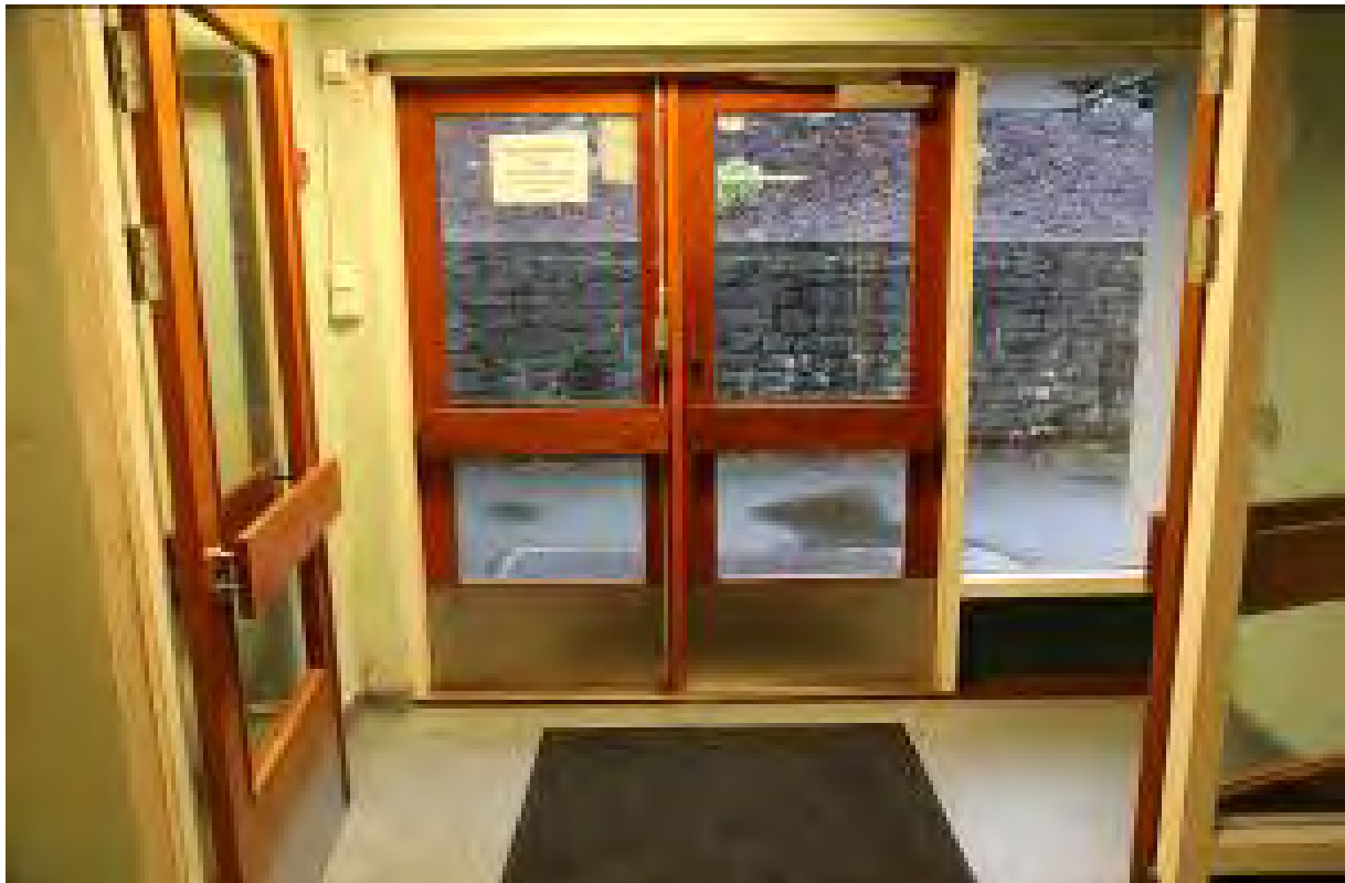
Figur 75 Doble teak- og glassdører med vindfang inn til garderoben.
