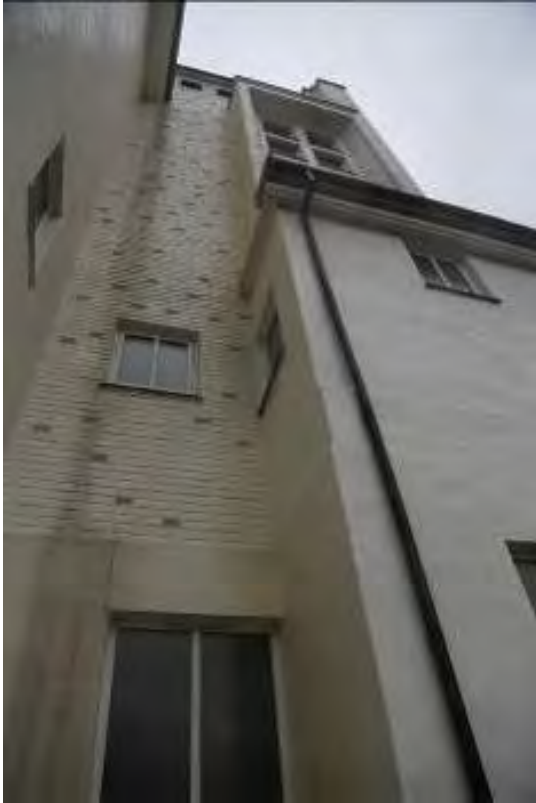
Figur 25 Trappetårnet i «vinkelen» har særlig forseggjort bruk av teglstein i relieff.
