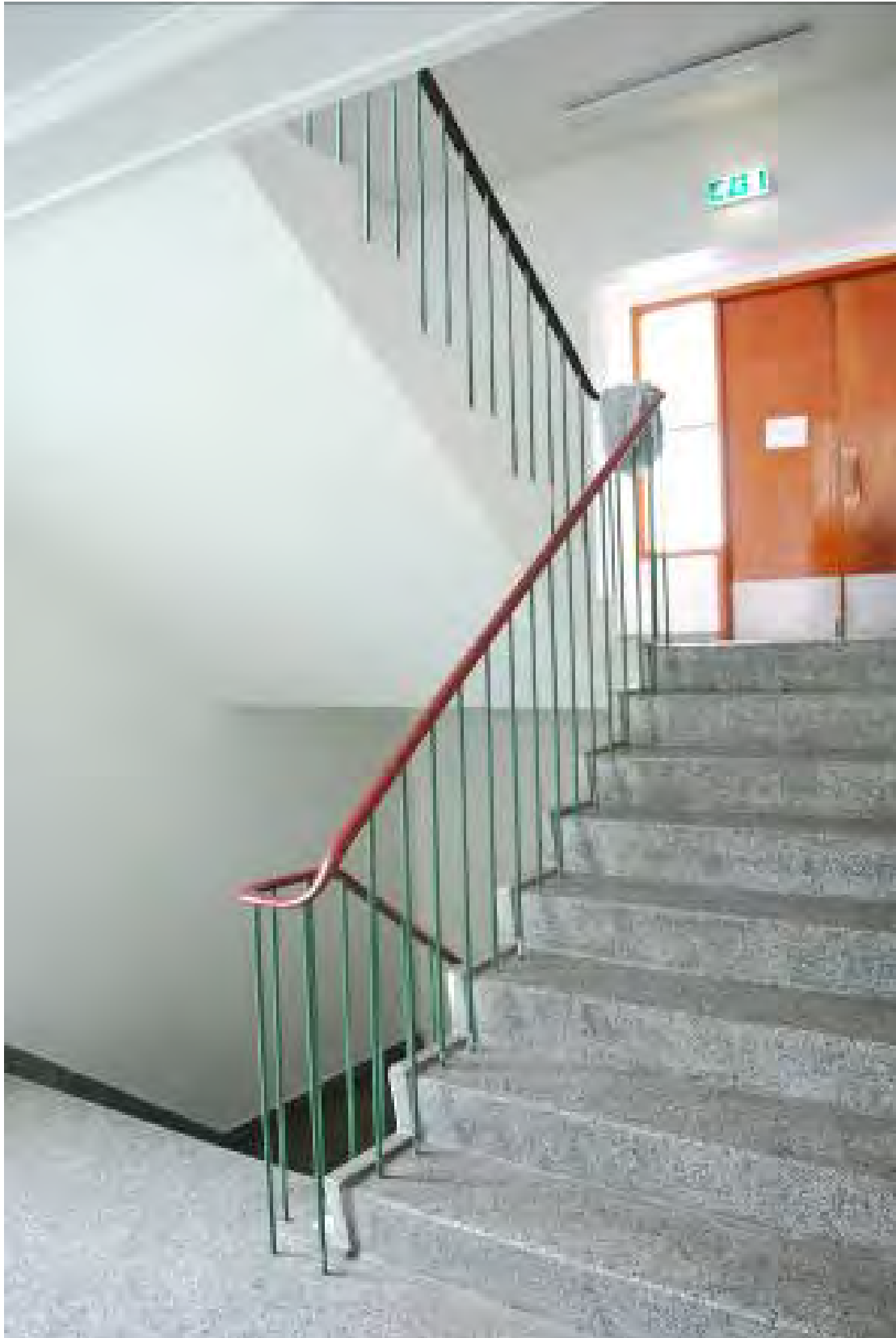
Figur 58 Trapperommene i 1959-delen har også tidstypiske og gode kvaliteter, med trapper i terrasso, enkle spilerekkverk i metall med håndløper av farget gummi.
