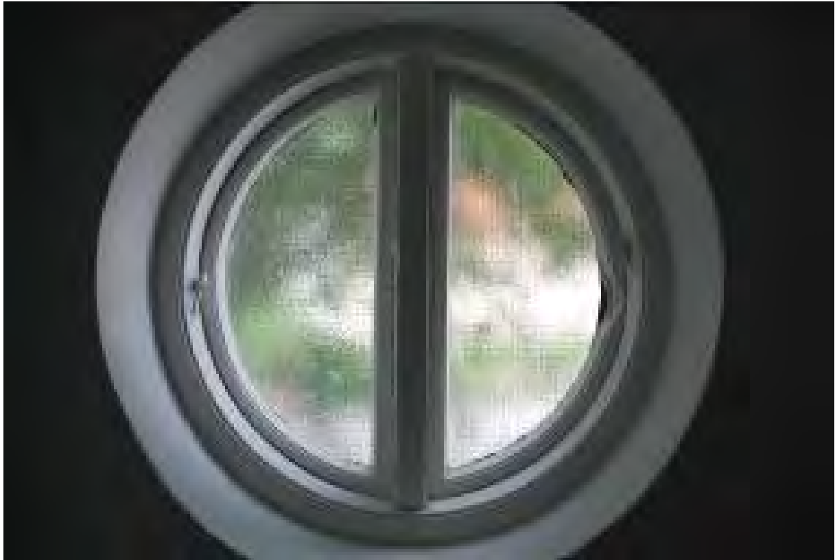
Figur 46 Disse runde vinduene finner vi på flere steder i bygningen, og alle vinduene er originale. Alle de andre vinduene er byttet ut.
