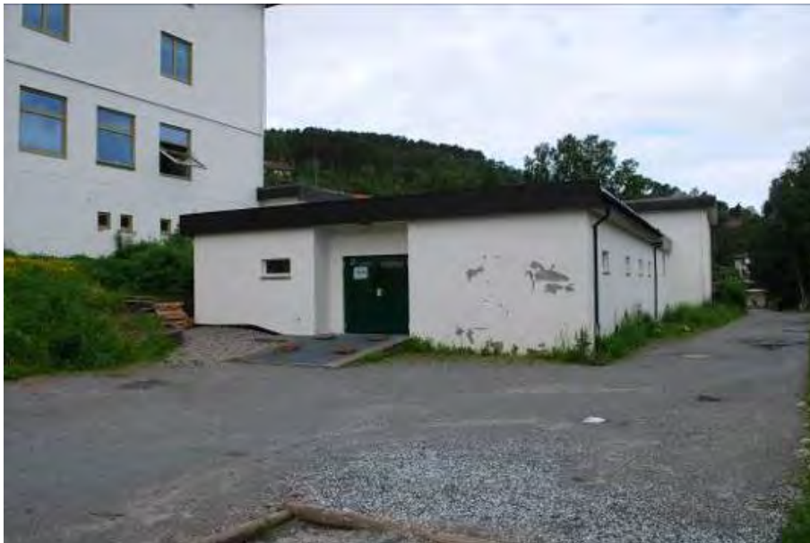
Figur 83 I 2002 ble det oppført et garderobetilbygg i tilknytning til gymnastikkbygningen fra 1970. Tilbygget er relativt godt tilpasset gymnastikksalen, med fasader av pusset betong og flatt tak med bred gesims. Tilbygget har ikke erkjent verneverdi.
