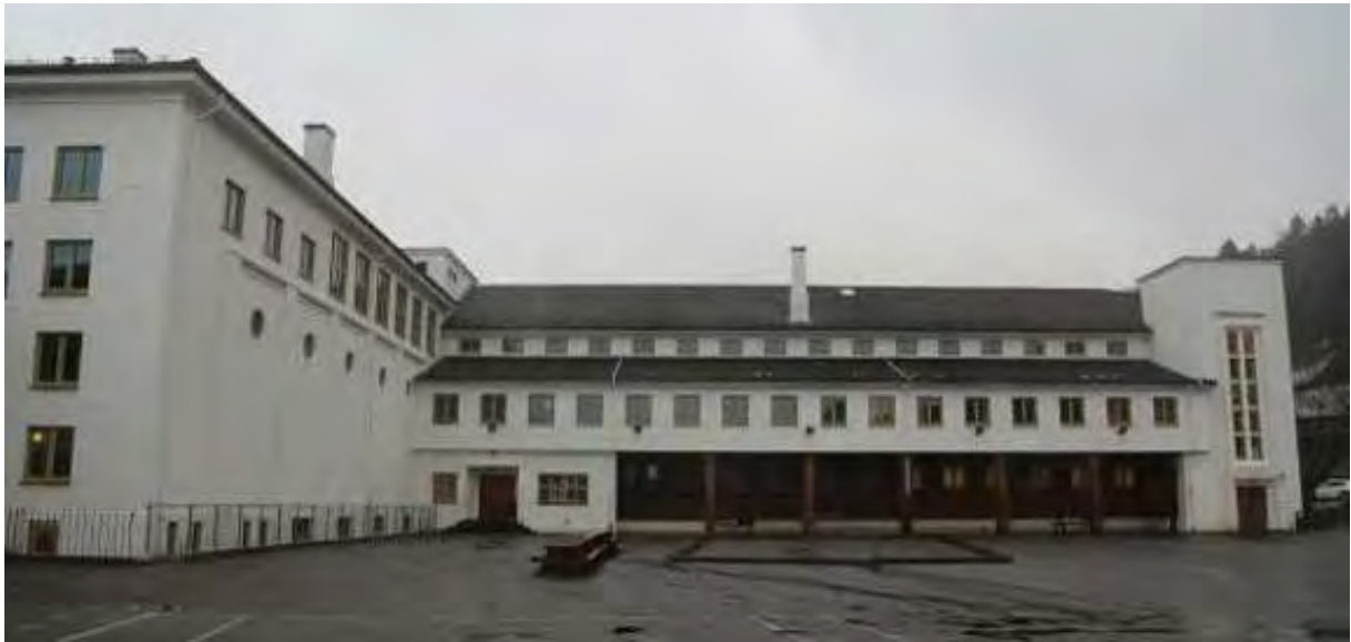
Figur 17 Vestfasade i klasseromsfløy. Like vinduer på rekke og to parallelle takflater forsterker også det horisontale preget i fløyen. Andre etasje er bredere enn første og tredje etasje. Tidlige tegningsutkast viser en smijernsaltan som ikke ble bygget – det kom i stedet pulttak og lave vinduer i øverste etasje.
