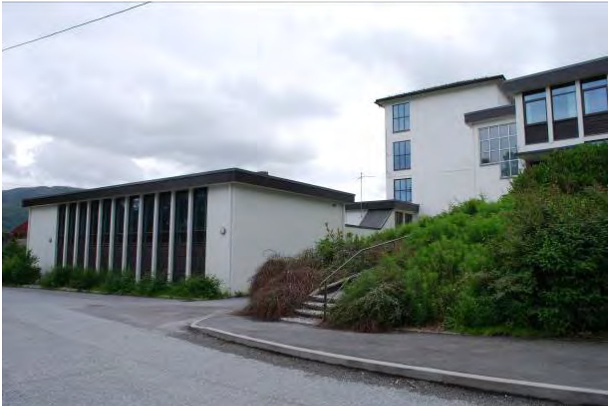
Figur 71 Gymsalsbygningen har samme fasadeoppbygging som administrasjonsfløyen, med brunbeisete vindusbrystninger og slanke, hvite betongsøyler. Den dobbelhøye gymsalen gir likevel høysmale vindusfelt, og rasterpreget uteblir.
