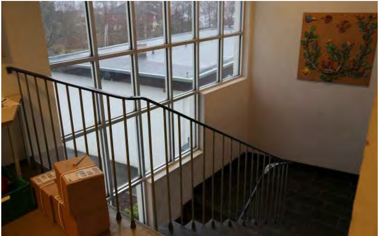
Figur 66 Intern trapp mellom etasjene i administrasjonsbygget. Det er trinn i skifer, enkelt spilerekkverk i metall med håndløper av gummi. Rommet preges ellers av det store, avtrappede vinduet, der vi skimter gymsalsfløyen nedenfor.
