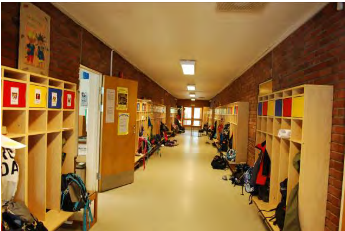
Figur 81 Bygningen har en ukomplisert plan; midtkorridor med klasserom på hver side og doble sett med glassdører i hver ende. Veggene er av rød teglstein.
