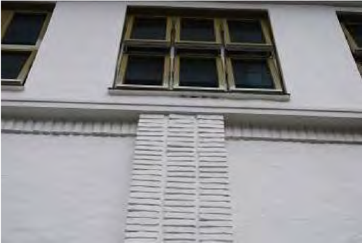
Figur 37 Detalj av støttepilar, som avsluttes i underkant av tredje etasje.
