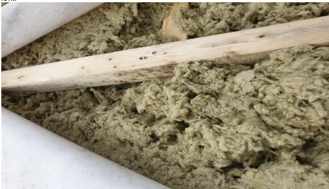
Figur 8: Snitt av undertaket og isolasjon.
