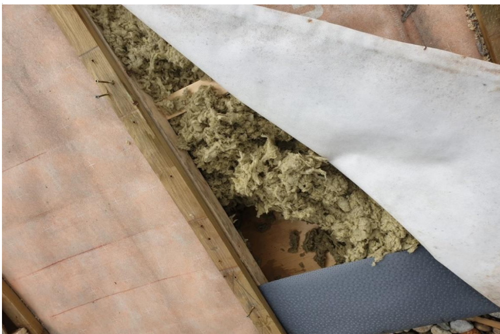
Figur 9: Snitt av taket med limtredeger i bunn.
