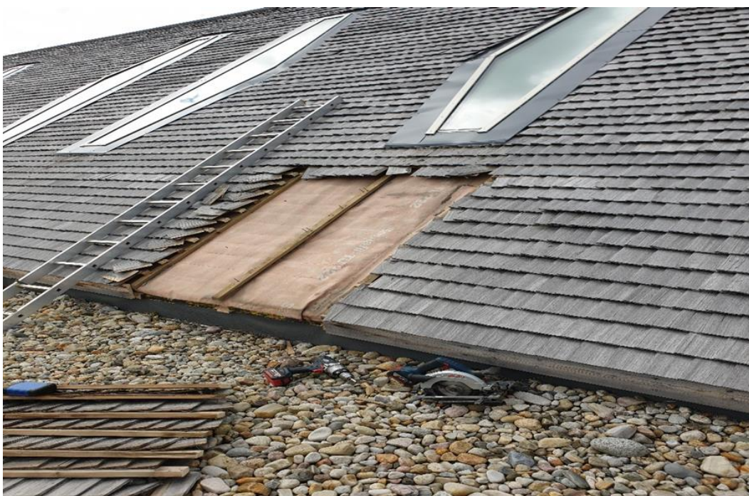
Figur 3: Taket demontert ved befaring.
