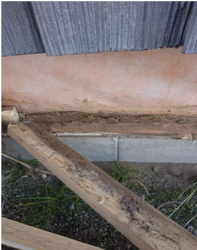
Figur 13: Nederste lekter demontert.
