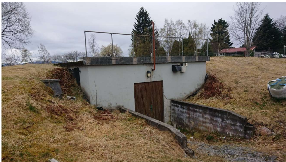
Figur 3 Eksisterende varmesentral i dag
