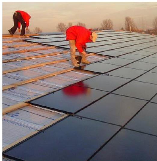
Figur V- 6 System montert på taket (Kilde: Donauer) Figur V- 7Integrert system (Kilde: Ernst Schweizer AG)
