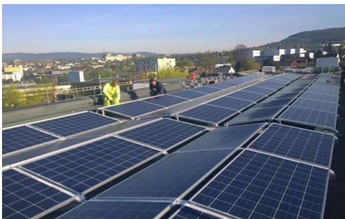
Figur V- 5 Eksempel på montasjesystem med øst-vest orientering (Bilde: Thor Christian Tuv, FUSen AS)
