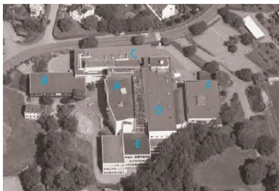
Oversikt over bygningsmassen
