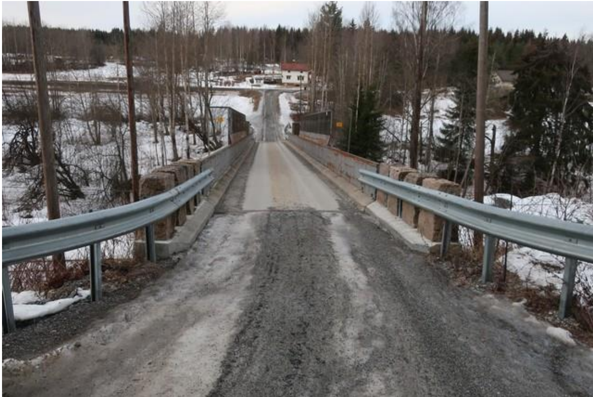
Bilde 8: Slitelag, rekkverk akse 1
