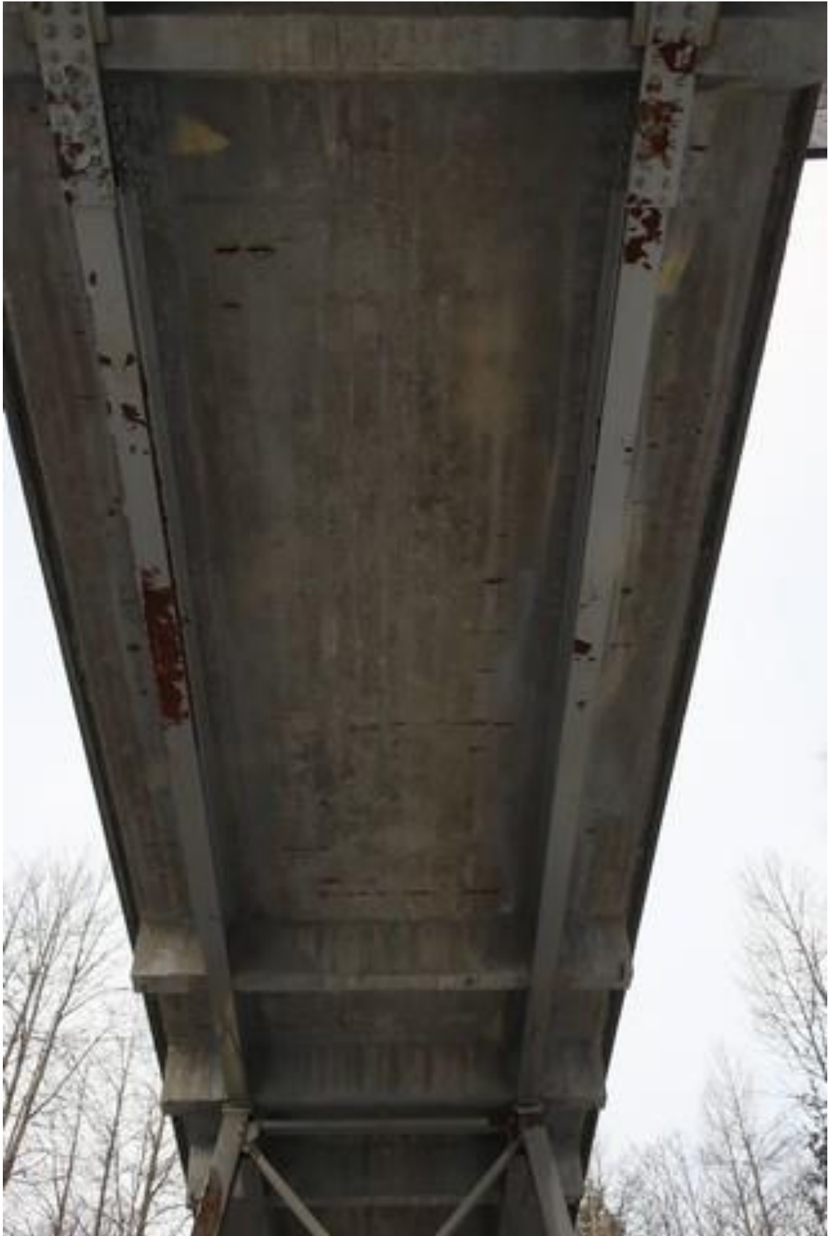
Bilde 5: Hovedbjelke, brudekke
