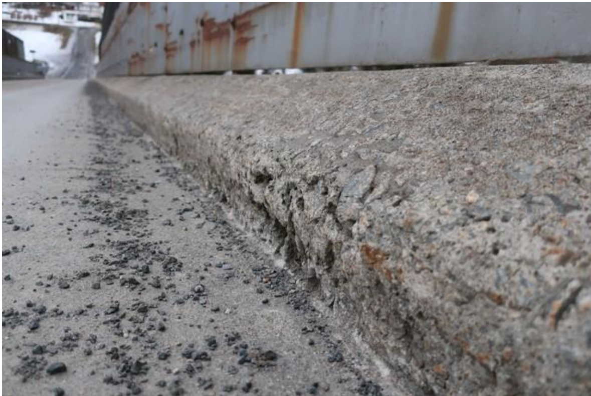
Bilde 13: Rekkverk (Skader i overflate, korrosjon mm)
