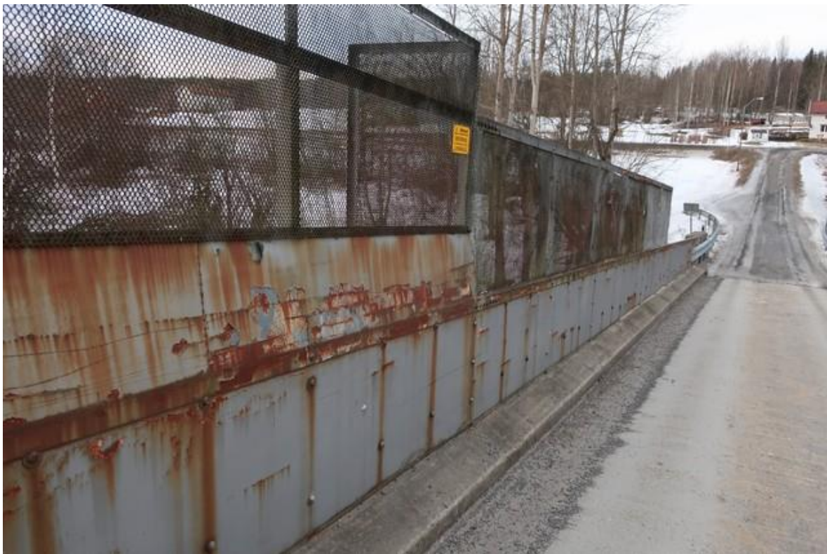
Bilde 13: Rekkverk (Skader i overflate, korrosjon mm)
