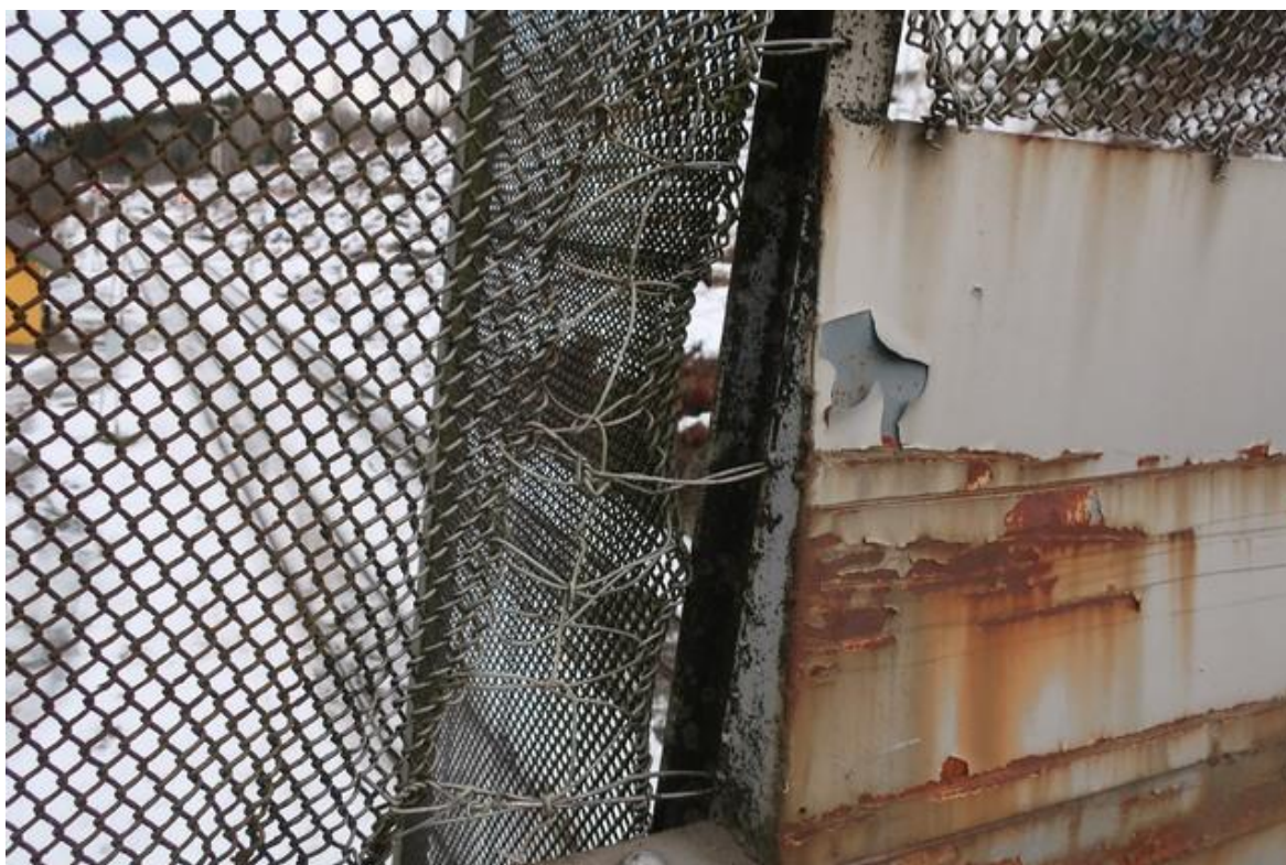
Bilde 15: Rekkverk (Skader i overflate, korrosjon mm)
