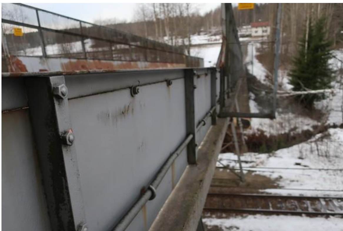
Bilde 15: Rekkverk (Skader i overflate, korrosjon mm)
