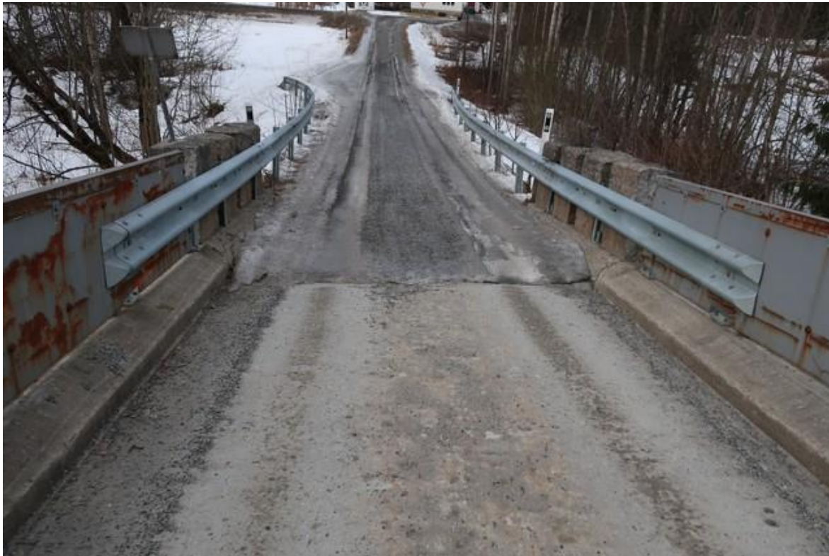
Bilde 9: Slitelag, rekkverk akse 5
