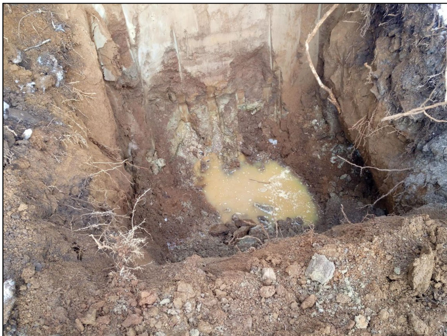
Bilde A-2. Prøvegrop PG2. Berg påtruffet på ca. 1 m. Løsmasser av sand/grus og jord.
