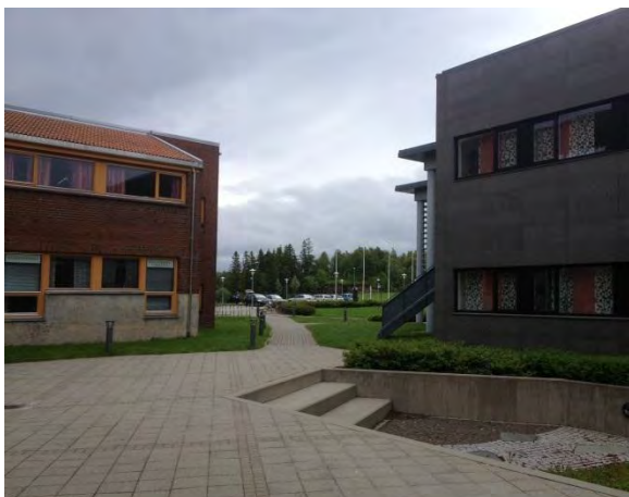
Atrium mellom biblioteket og handelsh gskolen, utsikt mot s rvest.
