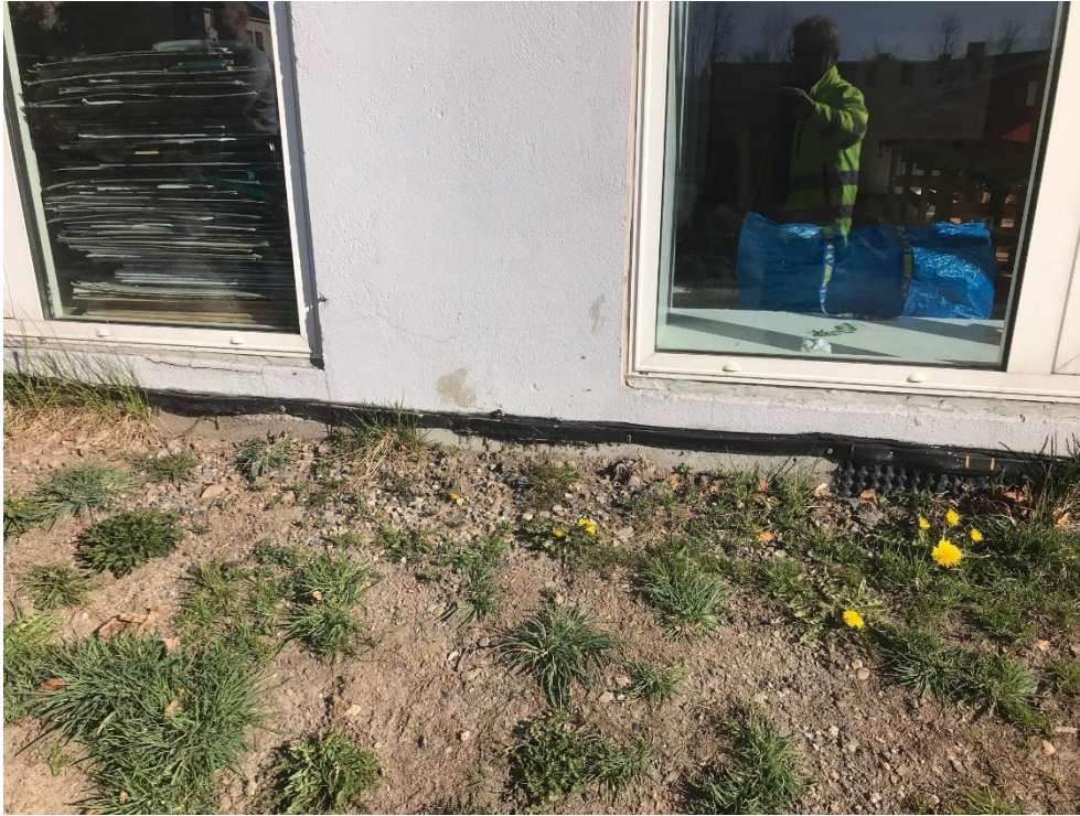
Vinduer som skal påsettes sålbenkebeslag og side-/overbeslag.
