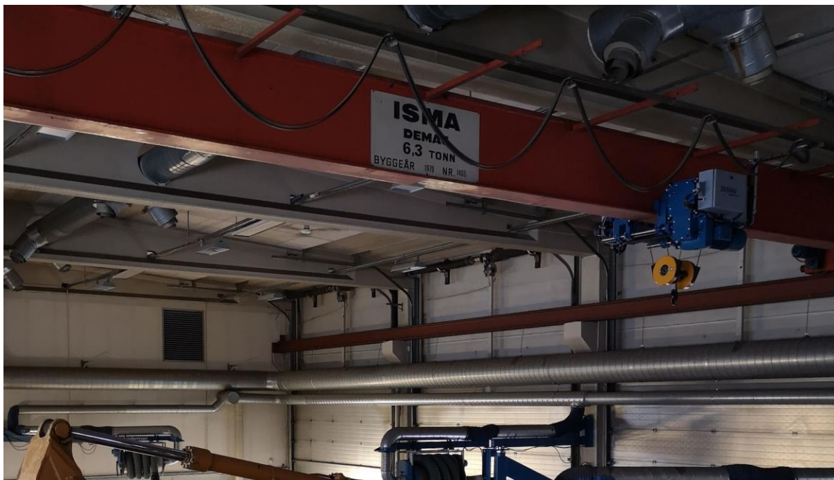
Bildet over viser eksisterende traverskran, løpekatt og kranbanebjelke
