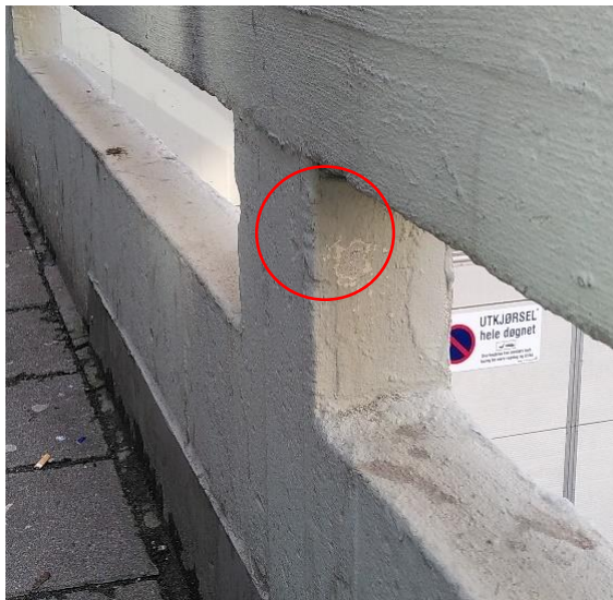
Bilde A3: Prøve P3, maling på betong (prøve tatt ved rekkverk rett bortenfor bygget).
