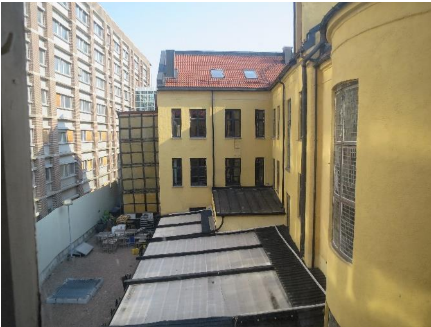
Figur 7. Bakgården i Møllergata 13. Ytre del av fløyen til venstre, inn til taknedløpet, skal rives ned til gulv 1. etasje.
