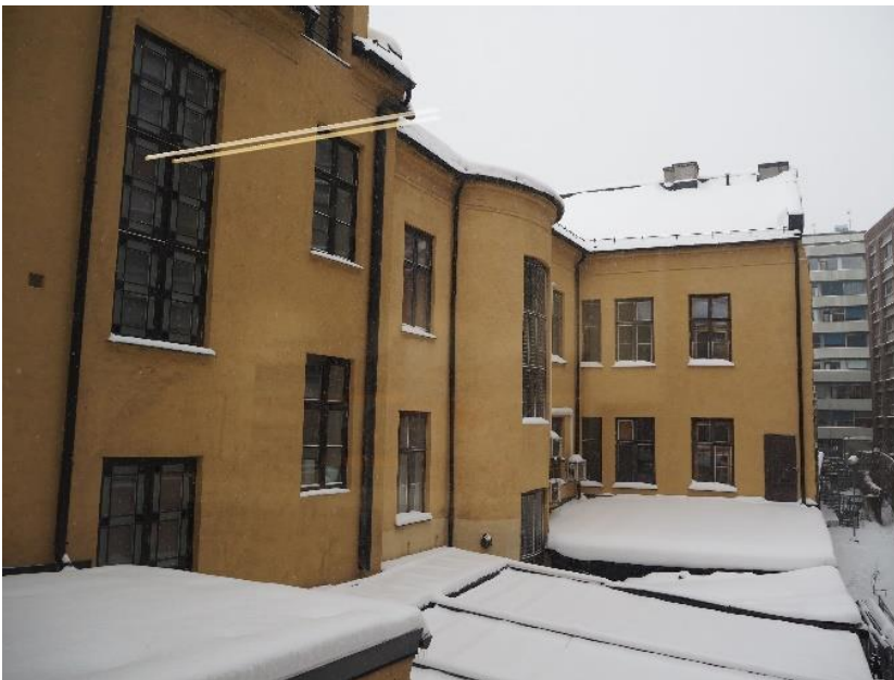
Figur 5. Bakgården i Møllergata 13B. Fløyen til høyre skal rives ned til gulv 1. etasje.
