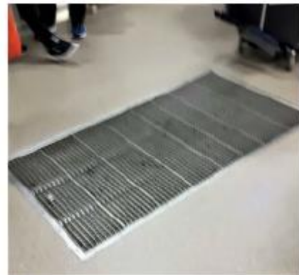
Referansebilde av gulvrist med sandfanger og sluk
