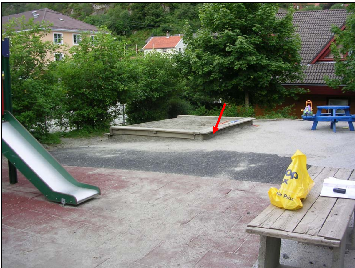
Trevirket rundt sandkassen på bildet inneholder CCA-impregnering.
