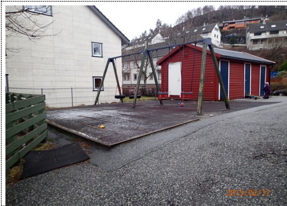
Bilde nr. 720.01 Utendørs konstruksjoner Bod for oppbevaring av leker.
