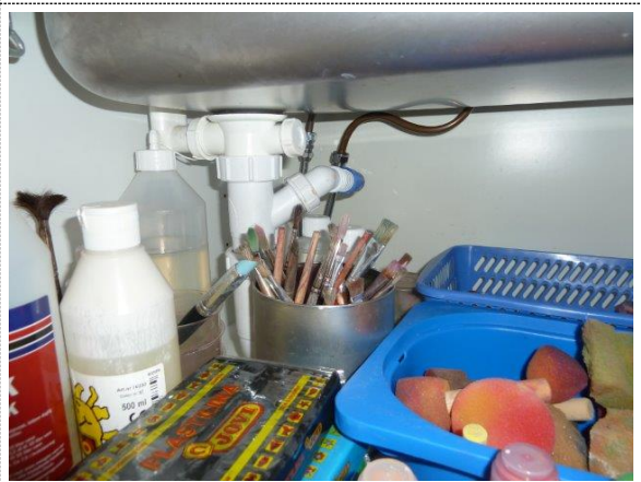
Bilde nr.310.19 Under vask på avdelingskjøkken
