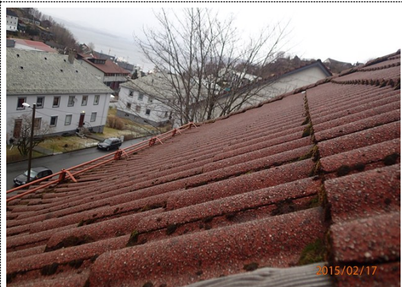
Bilde nr. 260.01 Yttertak
