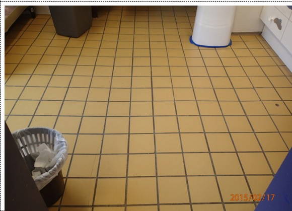
Bilde nr. 255.03 Gulvoverflater Noen arealer med flislagt gulv.
