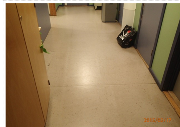
Bilde nr. 255.02 Gulvoverflater Gulvoverflater består av linoleumsbelegg Noen arealer har god kvalitet på overflate.
