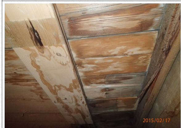
Bilde nr. 260.04 Yttertak
