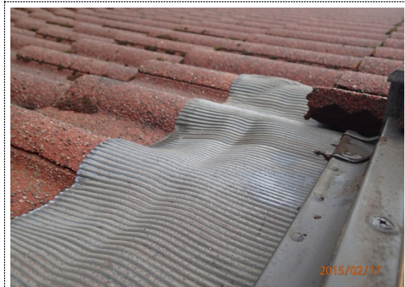
Bilde nr. 260.02 Yttertak
