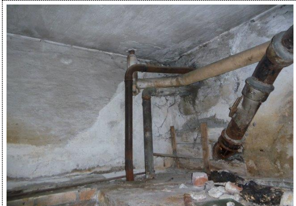
Bilde nr.690.03 Lufting og påfylling av oljetank.
