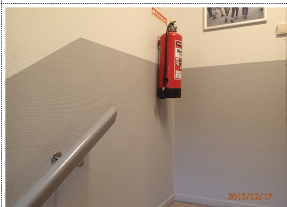
Bilde nr. 240.03 Innervegger Innervegger i trapperom fra 1. til 2. etg. Tapetsert murvegg. Overflater i god stand.
