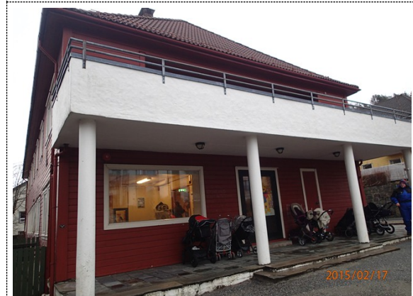
Bilde nr. 250.02 Dekker Betongdekke med bæring på søyler.
