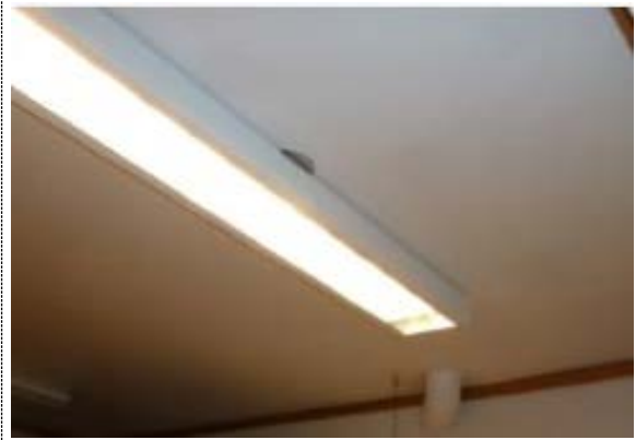
Bilde nr.440.04 Belysning bad
