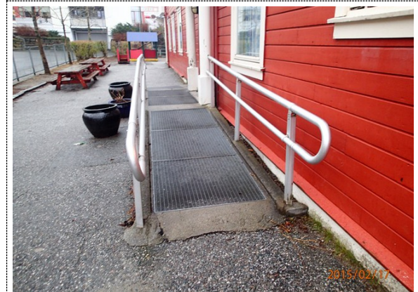
Bilde nr. 903.01 Universell utforming. Det er anlagt rampe ved inngang til barnehagen.
