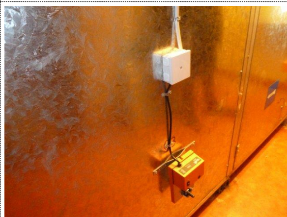
Bilde nr.360.03 Spjeldmotor for bypass på kryssveksler
