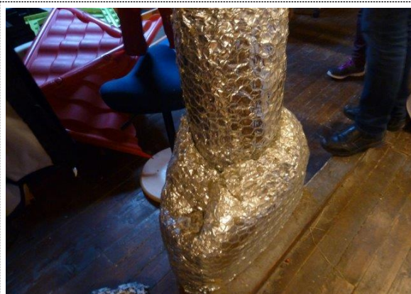
Bilde nr.360.11 Brannisolert på loft.
