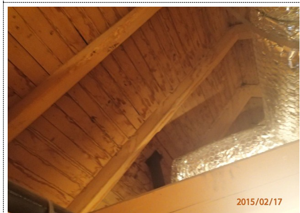
Bilde nr. 260.06 Yttertak
