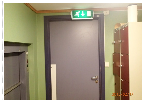
Bilde nr. 244.04 Innvendige vinduer og dører Dør med god kvalitet.
