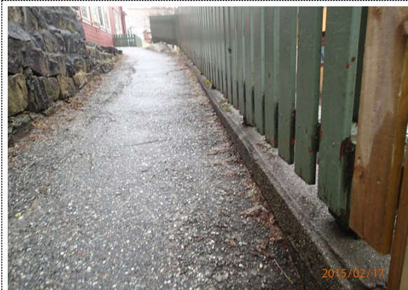
Bilde nr. 721.01 Støttemurer og andre murer. Gangvei ned mot lekearealer på nedsiden av barnehagen.
