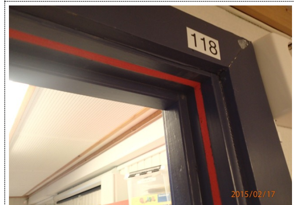
Bilde nr. 244.02 Innvendige vinduer og dører Dører i god stand. Dør til lekerom 118
