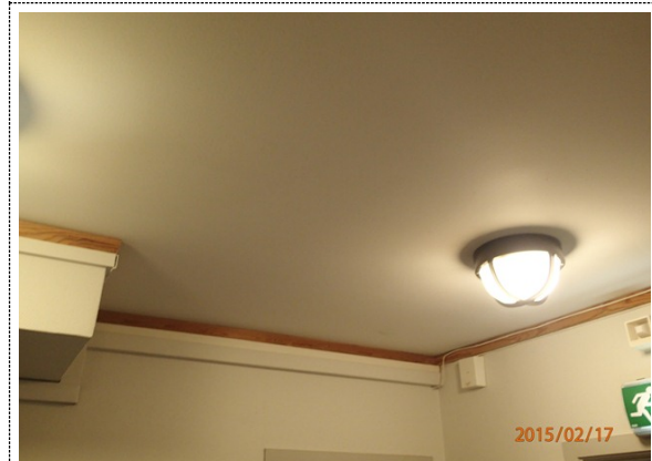
Bilde nr. 256.04 Himlinger Malte himling. Gips / trefiberplater.
