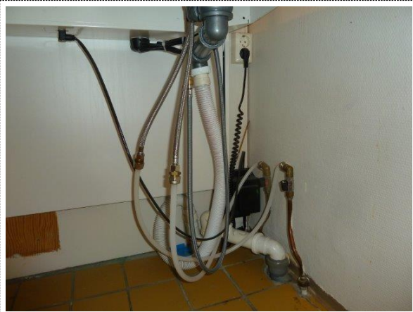
Bilde nr.310.17 Tilkobling med fleksible slanger på hev senk bord.
