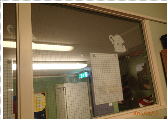
Bilde nr. 244.01 Innvendige vinduer og dører Innvendig vindu i god stand.
