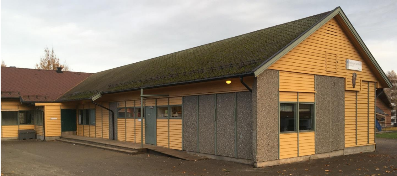
Bilde 1: Bygg A, fasade mot vest og sør.
