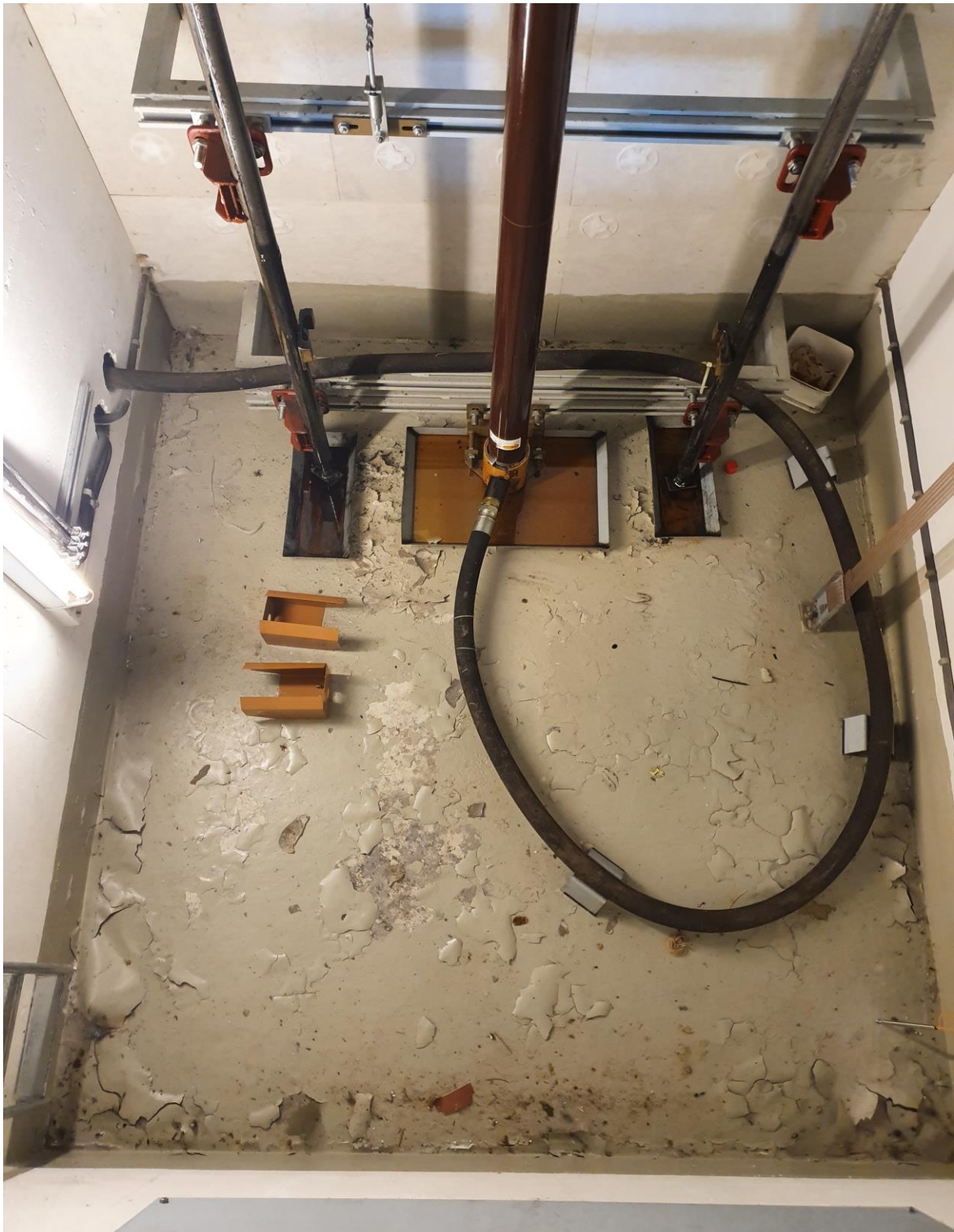
2.01.2 Gruven – Tilbyder må renske maling, tørke opp og male med oljebestandig maling. (kontroll av fuktighet før maling).
