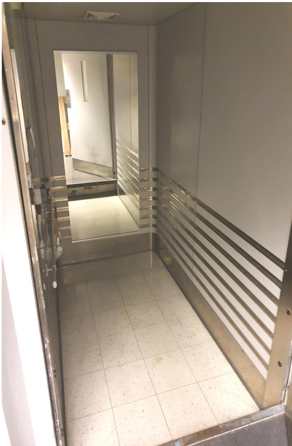
2.01.3 Heiskupe – Demonteres og leveres til godkjent deponi.
