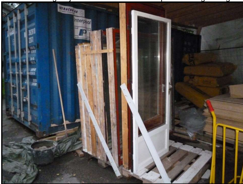
Figur 9: Slik kan vinduer og balkongdører klargjøres for transport.
