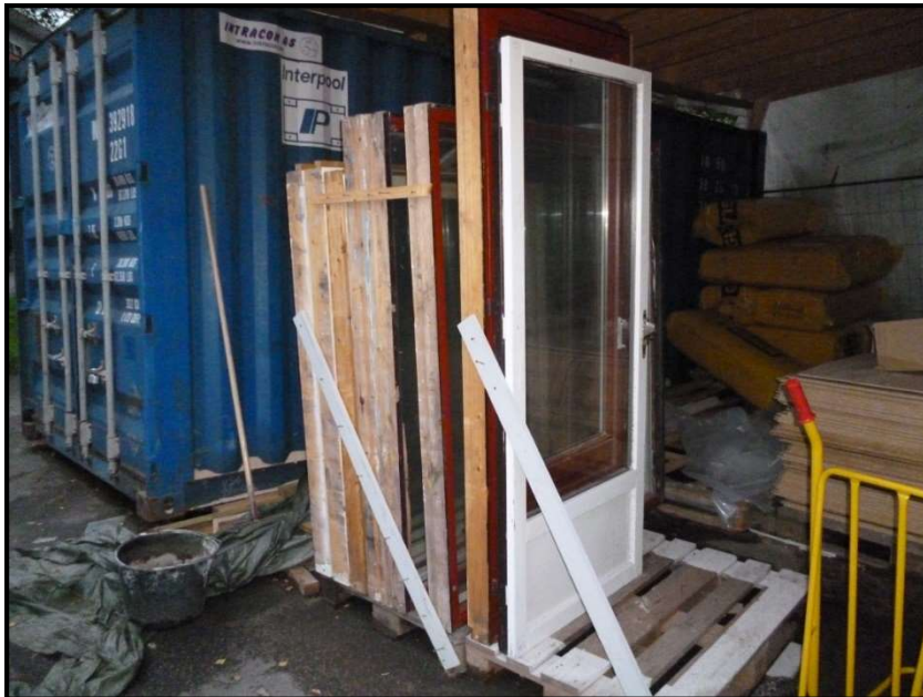
Figur 4: Slik kan vinduer og balkongdører klargjøres for transport.
