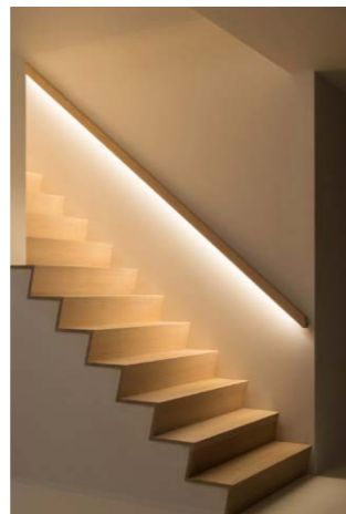
LØSNING MED LINEÆR LEDSTRIP
