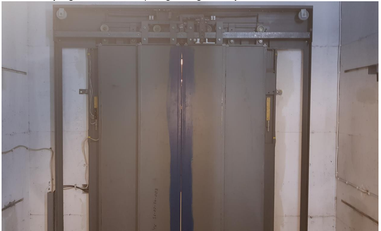
2.01.6 Bilde av sjaktdører på side B.
