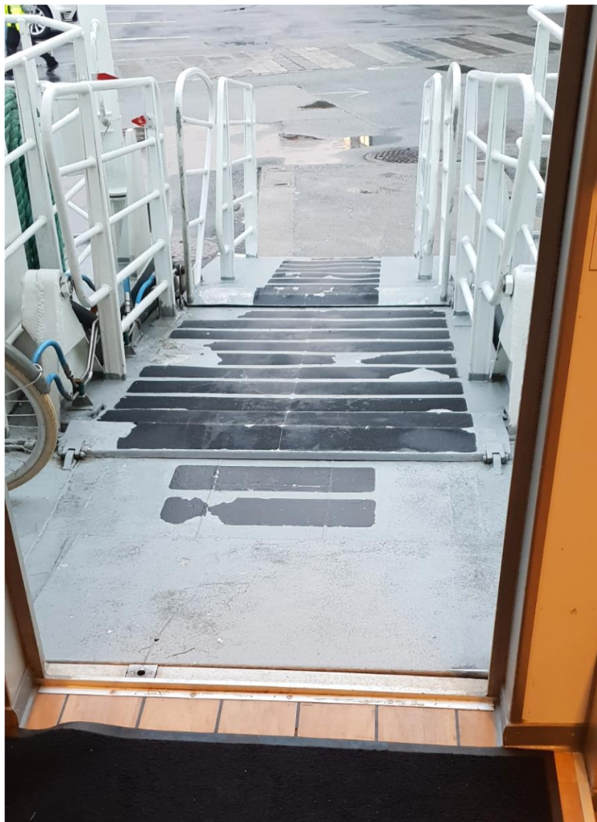
Figur 23 Flerleddet gangvei for ombordstigning (Foto: Svein Ystanes, Kolumbus)
