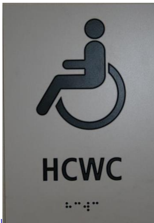
Figur 39 Skilt med god kontrast, relieff tegning og skrift, samt punktskrift (Foto: Universell Utforming AS)
