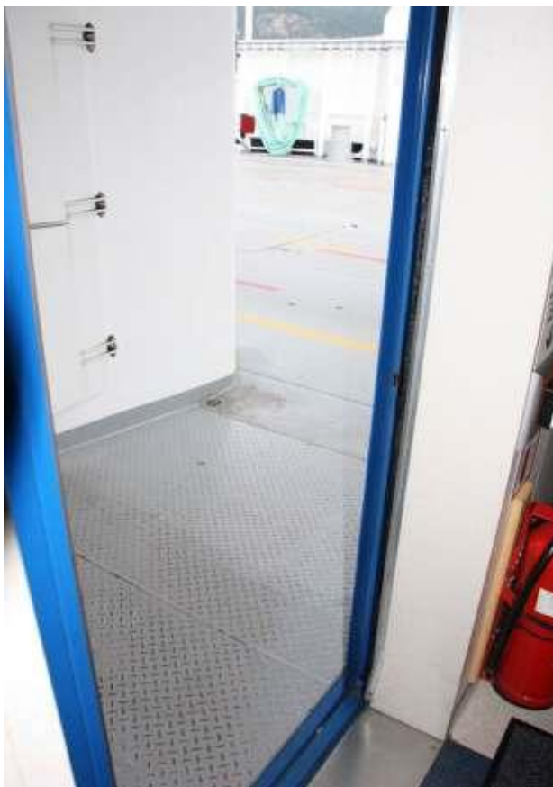
Figur 30 Trinnfri adkomst til salong, med automatisk skyvedør (Foto: Fredrik Nårstad Jensen/Statens vegvesen)
