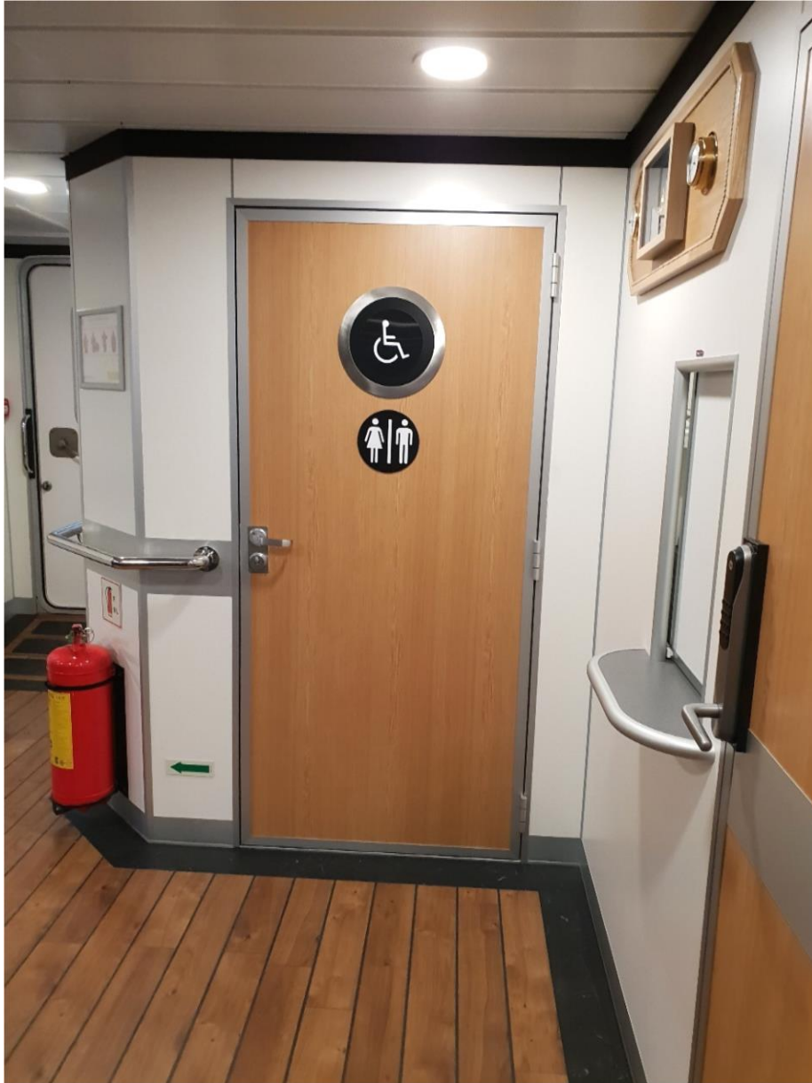
Figur 37 Dører skal være synlige mot veggen, anbefalt kontrast er minimum 0,4. Merk støttehåndtak. (Foto: Kolumbus)
