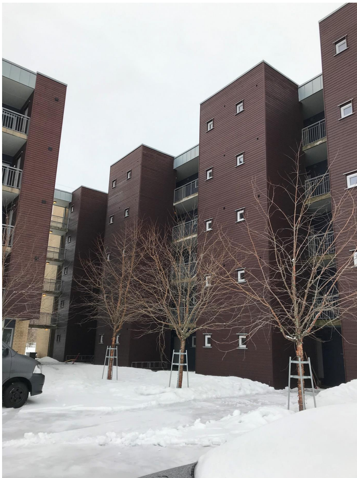
Bilde 3 : Mer av fasade Nordvest (Bygg 2)
