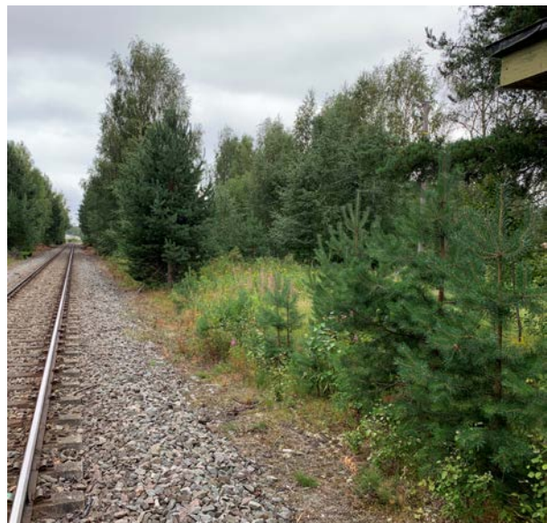
Figur 2.2 Bilde av terreng på sørsiden av Solørbanen.
