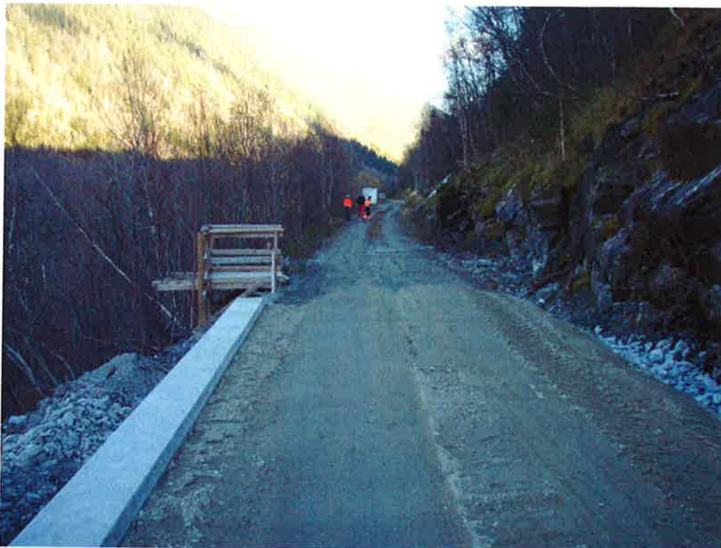
Foto 14: Profil 1110-1130, "Raset", ny støttemur på nedsiden av vegen, bilde fra Vemork
