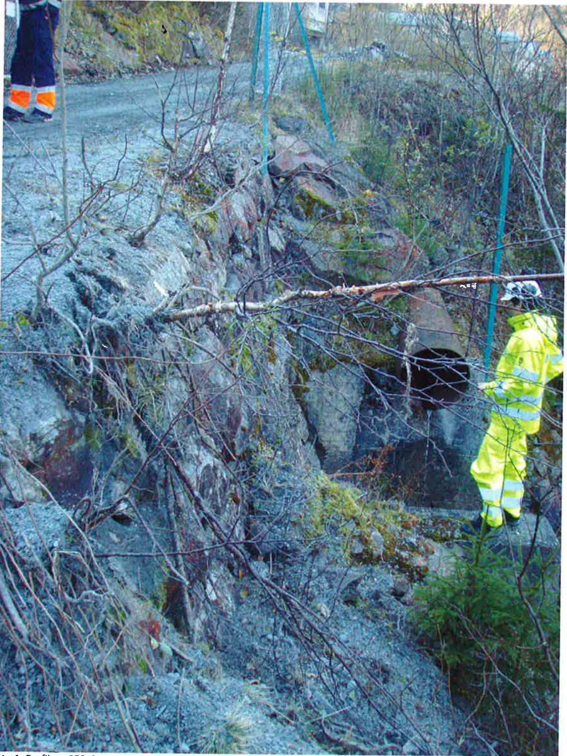
Foto 1: Profil ca. 250, Støttemur med stikkrenner
