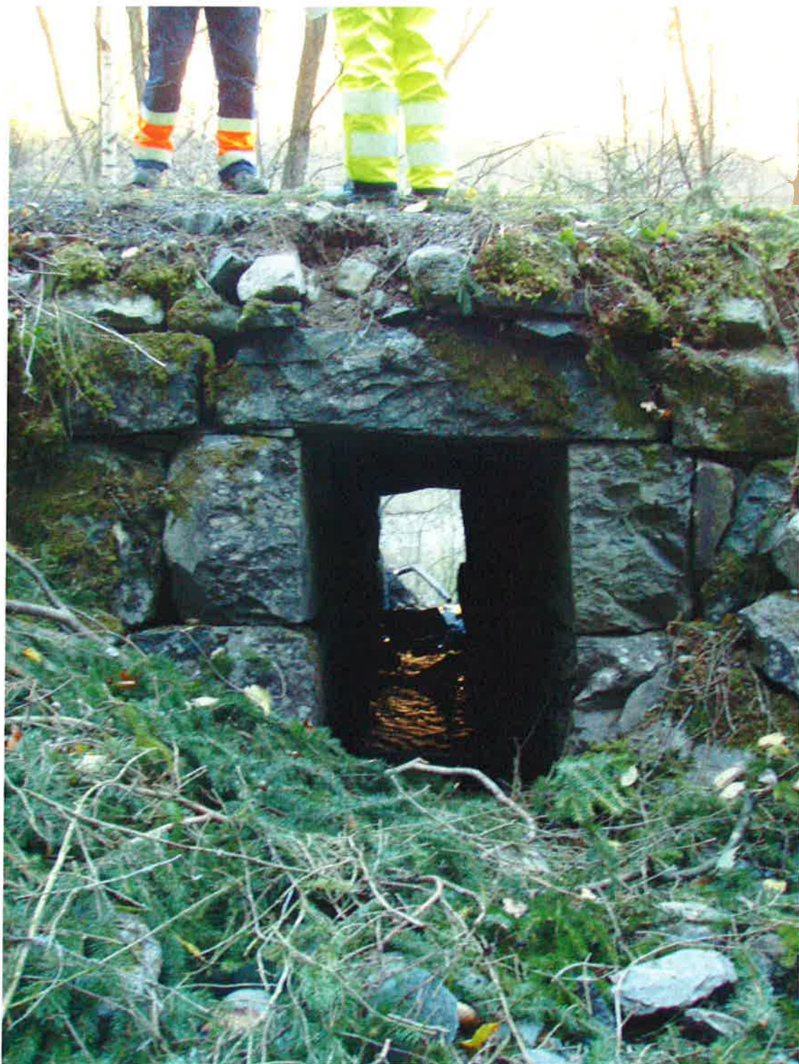
Foto 26: Profil 1170-1180, Stikkrenne av stablet stein
