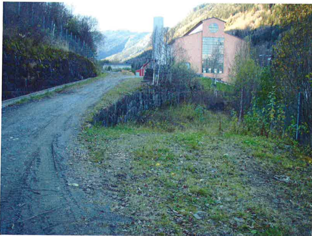
Foto 30: Profil 3200-3230, Støttemur. Smalt der muren ligger nærmest vegen
