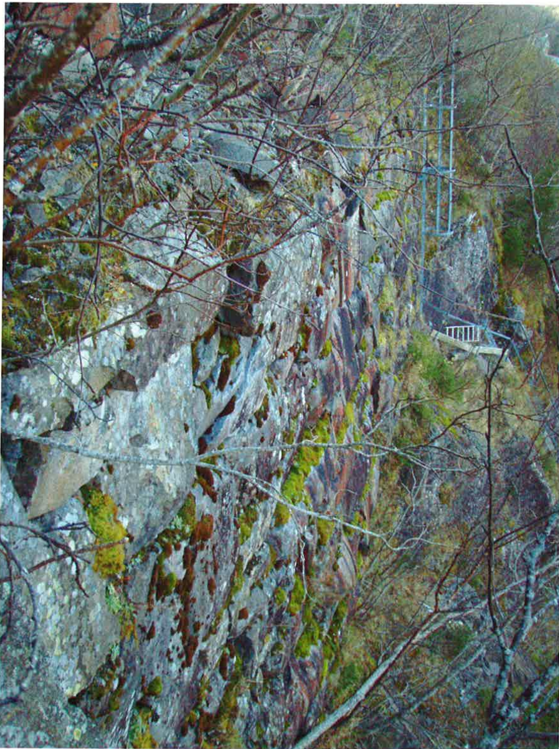
Foto 10: Profil 530-590, Støttemur delvis betong og stein
