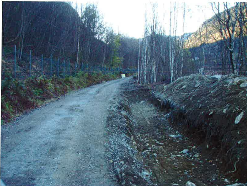
Foto 32: Profil 3730, Bilde langs vegen, mot Vemork
