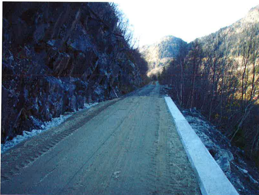
Foto 13: Profil 1110-1130, "Raset", ny støttemur på nedsiden av veggen, bilde mot Vemork
