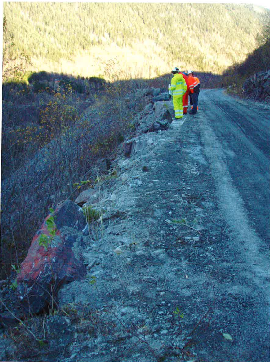
Foto 7: Profil 300-400, Eldre støttemur med plastring av blokkstein
