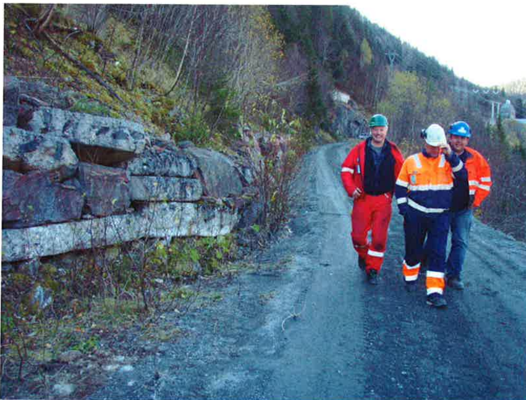
Foto 5: Profil 300-400, Utbulning registrert på nedsiden av vegen, vegen utvides noe på innsiden
