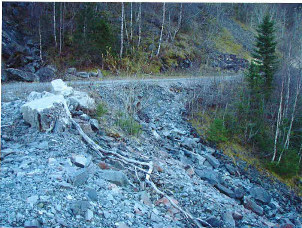
Foto 17: Profil 180, Stikkrenner av betong
