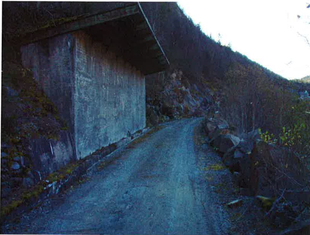
Foto 12: Profil 730, Rasoverbygg, eldre støttemur med plastring av blokkstein på utsiden
