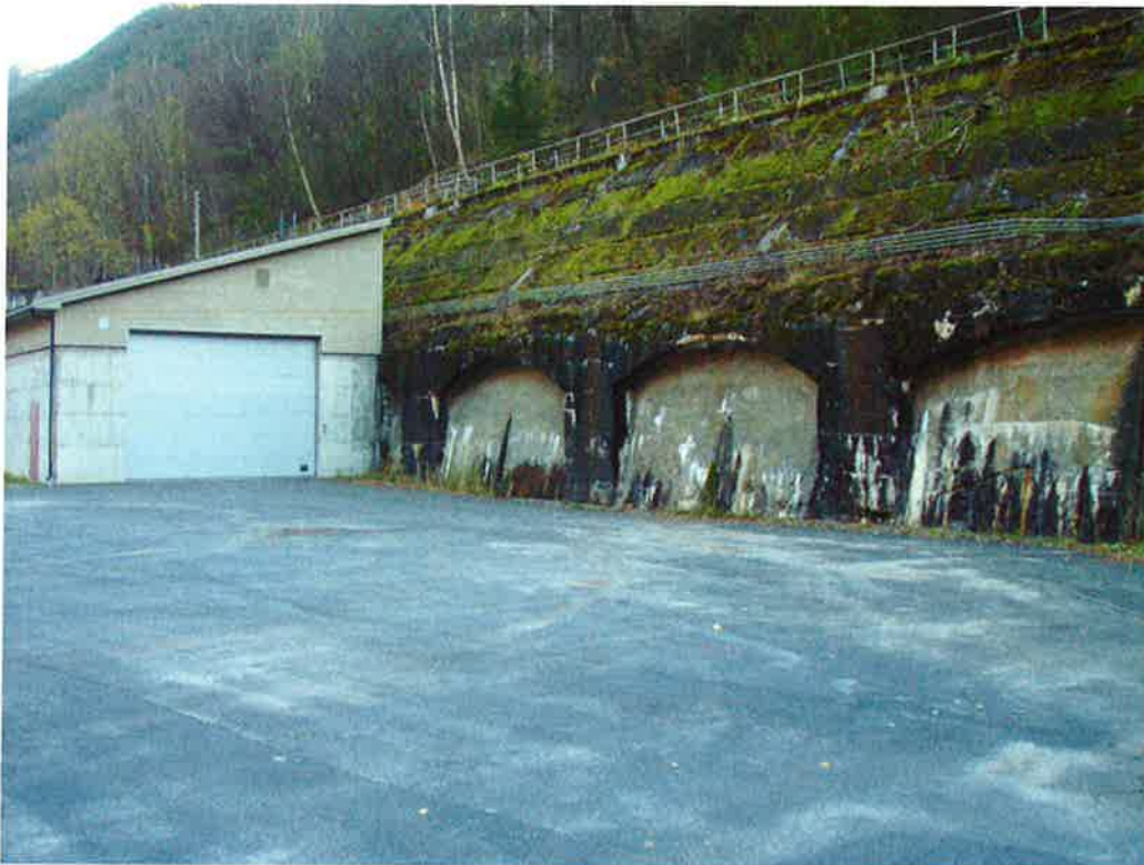
Foto 31: Profil 3350-3430, Høy støttemur av betong og betongelementer på vegens nedside
