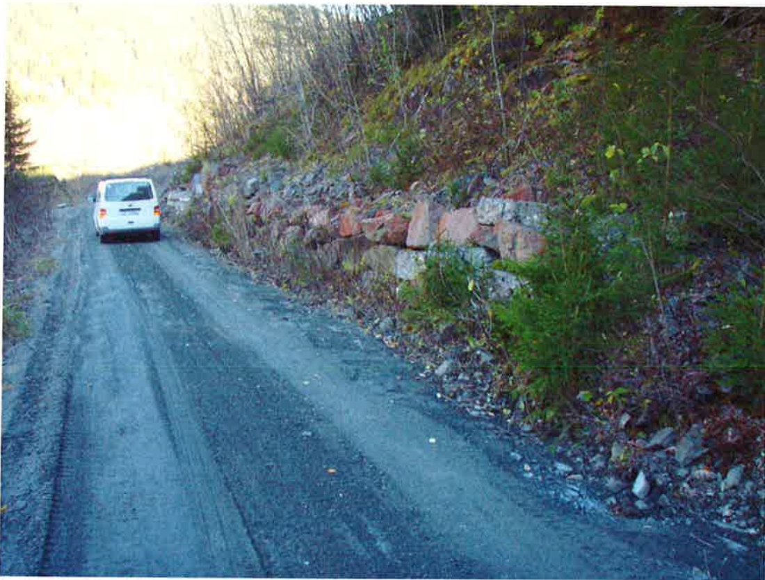
Foto 3: Profil 300 - 400, Støttemur på vegens overside
