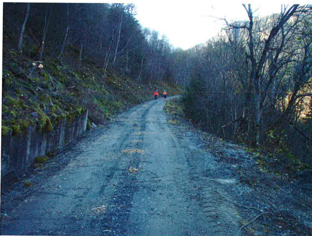
Foto 21: Profil 600, Bilde langs vegen, mot Vemork
