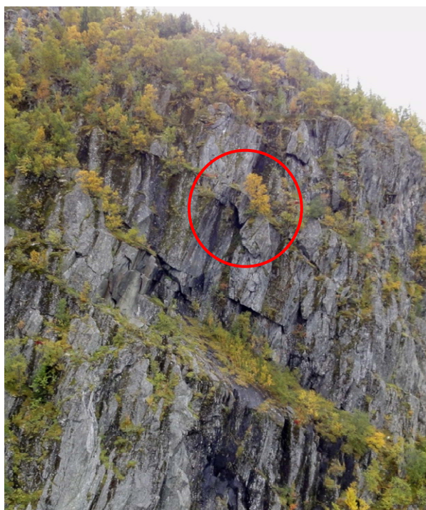
Figur 16: Øvre parti av vestlig del av Klokkshovd. Blokkene markert med rød sirkel ser spesielt ustabile ut. Utfall fra dette området vil trolig ikke nå veien.
