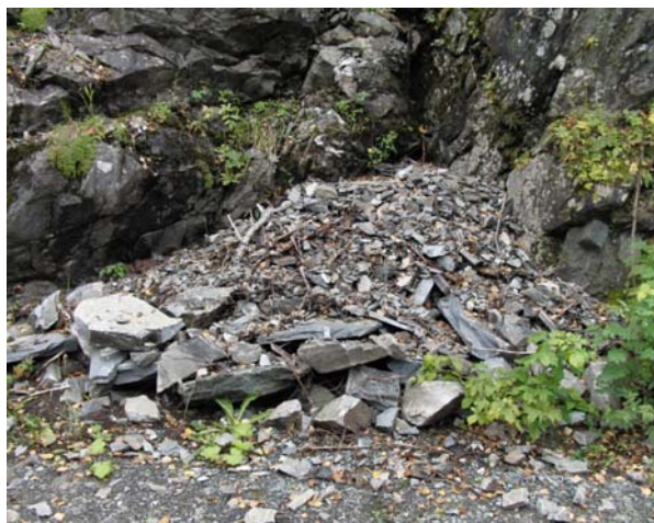
Figur 8: a) Et mindre utfall i veikanten var betydelig oppknust, men bestod også av større blokker. Utfallet har ikke nådd veien, med mindre det har blitt ryddet før befarings. b) Steinspranget har blitt utløst fra et område lenger opp som ikke var synlig fra veien, og kanalisert nedover denne renna synlig midt i bildet.
