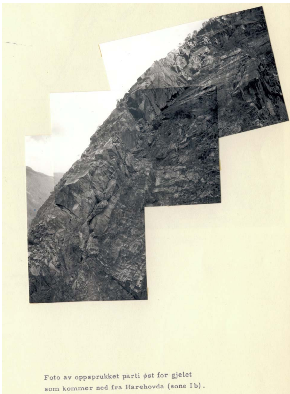
Figur 26: Oppsprukket parti på østsiden av Harehovdagjelet sett fra vestlig side, mot øst. Her kan tydelig sprekkeflaten som skjærer partiet i underkant sees i øvre foto (Jørstad 1961).
