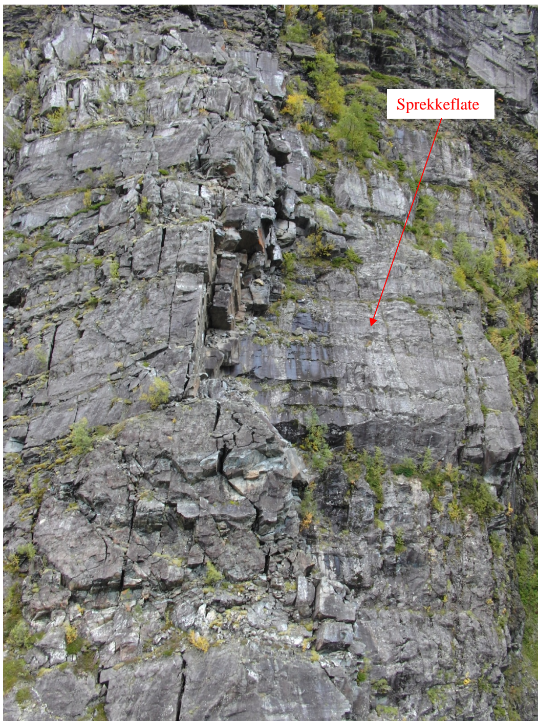
Figur 24: Midtre del av det oppsprukne partiet på østsiden av Harehovdagjelet. Partiet kan ses å være meget løst, med blokker i stabler. Sprekkeflaten som avskjærer partiet i underkant er markert.
