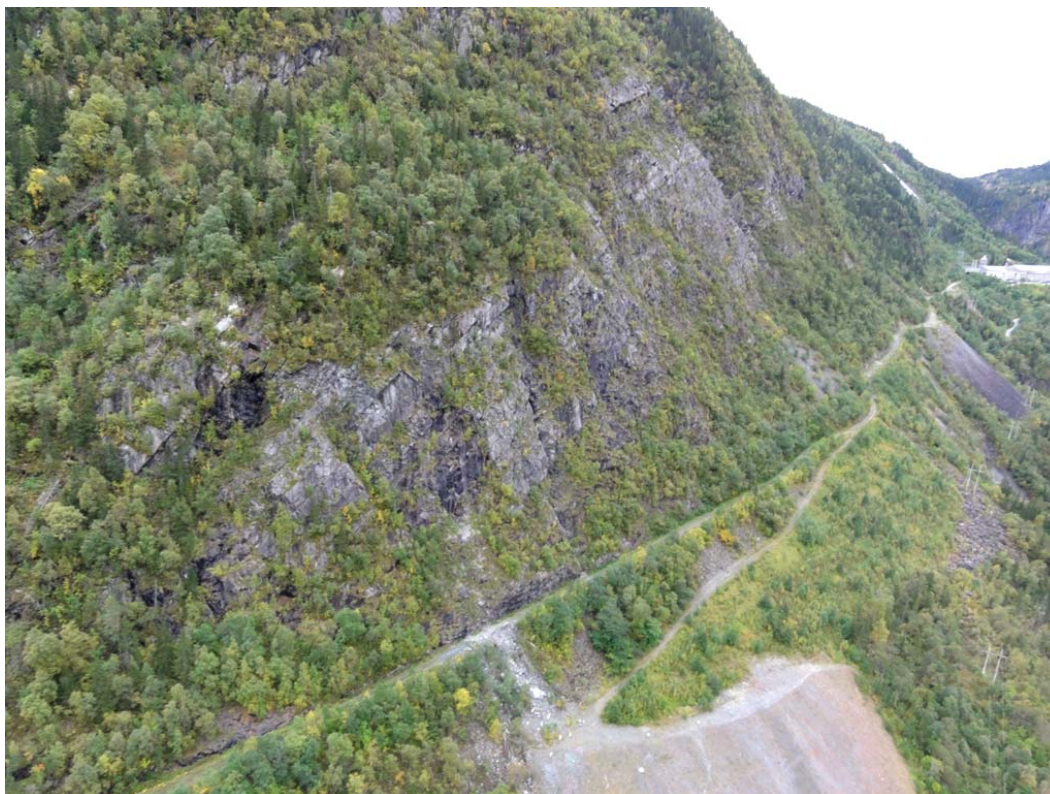
Figur 18: Oversiktsfoto over strekningen fra tipp 3 til Vemork. Et steinsprang kan ses å ha løsnet i den steile fjellsiden over tipp 3 og tatt med seg deler av veien. Steinspranget er omtalt i kapittel 5 og vist i figur 5 og figur 6. Hele dette området er sterkt oppsprukket og flere ufall mot veien må påregnes.
