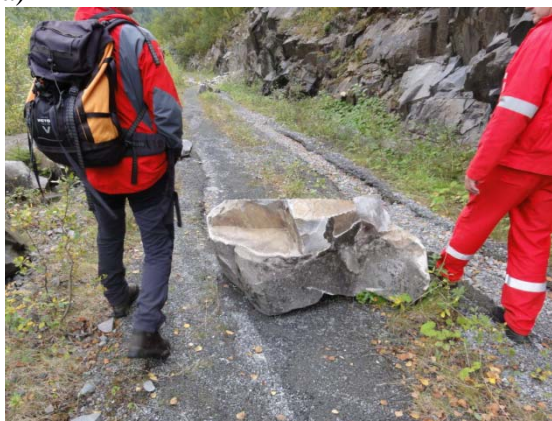
Figur 11: a) Utfallet ses i forgrunnen; en større stein har falt ut på veien. b) Utløsningsområdet. Her er fjellet oppsprukket, og særlig i øvre kant er det løst berg. Herfra kan flere utfall komme.
