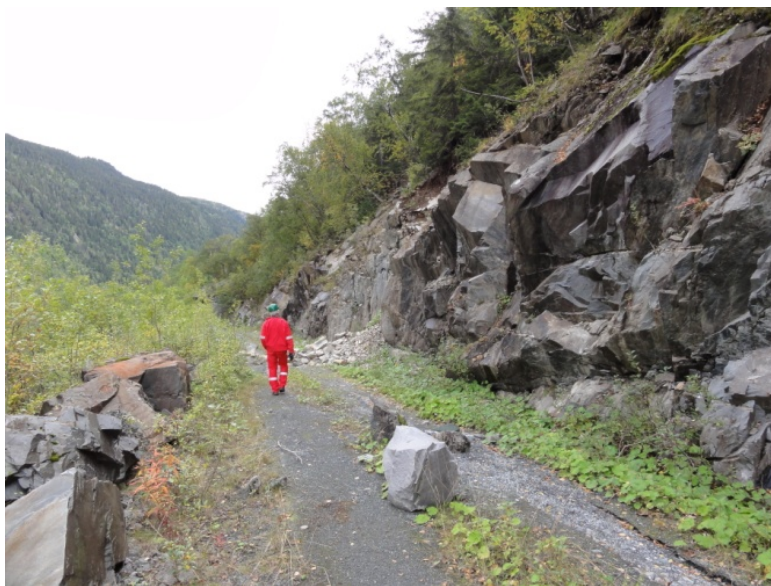
Figur 10: Steinsprang observert langs veistrekningen. Utfallet ses i forgrunnen: tre steiner har falt ut og nådd veien. Steinspranget omtalt i figur 9 ses i bakgrunn.
