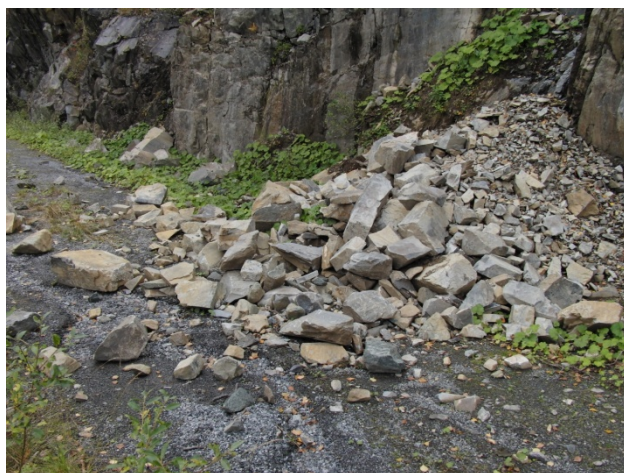
Figur 9: a) Dette utfallet har et større volum, og ligger vis a vis Våer øst. Utfallet består av godt oppknust materiale, samt en del større blokker som har kommet helt ut i veien. b) Utløsningsområdet har en vifteform og ligger like over veibanen. Et bergparti som sannsynligvis var meget oppsprukket har glidd ut.
