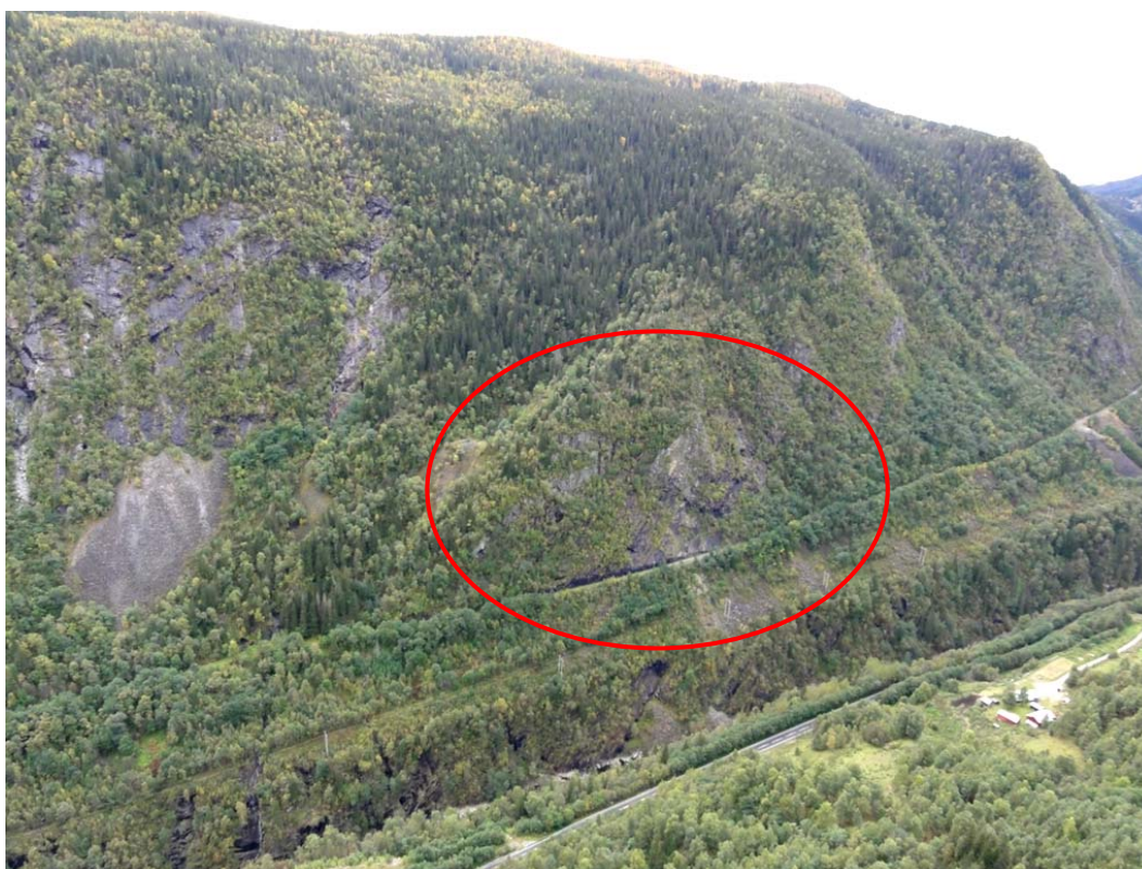
Figur 17: Oversiktsfoto over strekningen fra Gjuvbekken og til tipp 3, hvor sabotørstien kommer opp. Steinspranget vis a vis Veset (omtalt i kapittel 5 og vist i figur 4) har gått fra partiet innringet i rødt. Flere utfall kan komme fra dette området, beskrevet nærmere i figur 19.
