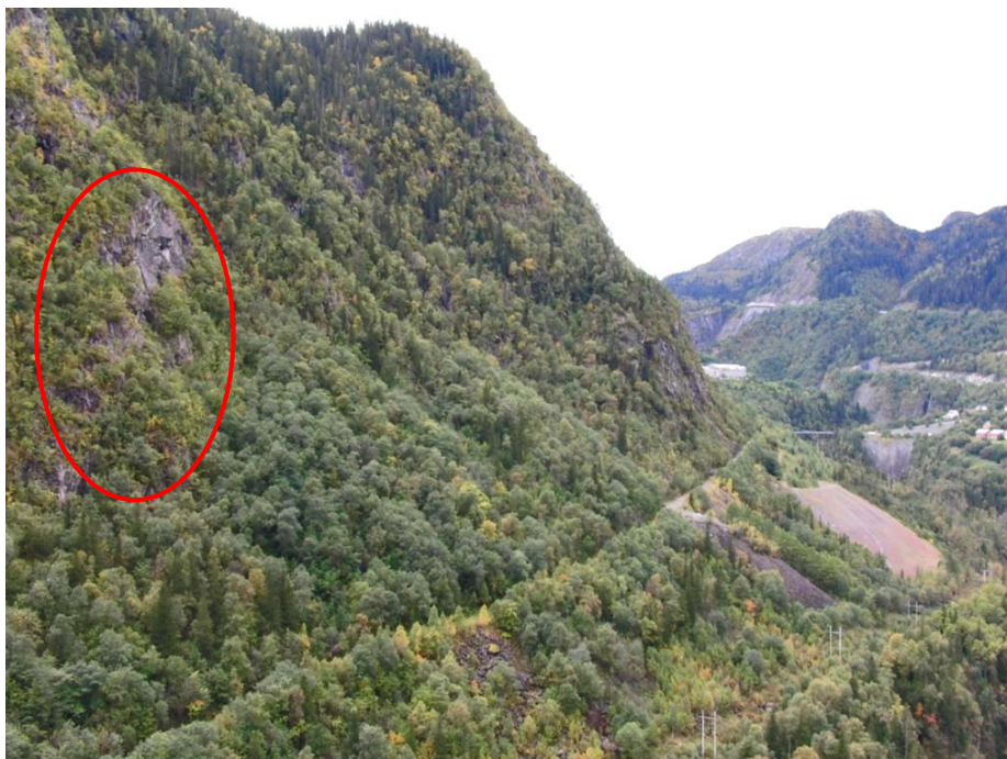
Figur 20: Veistrekningen som går under Rånåberg mellom områdene vis a vis Veset og Flåten har større avsand til bratte fjellskrenter hvor steinsprang kan utløses. Det er sannsynlig at blokkutfall fra bratte områder, som det innringet i rødt, vil stoppe i den skogkledde lia under.
