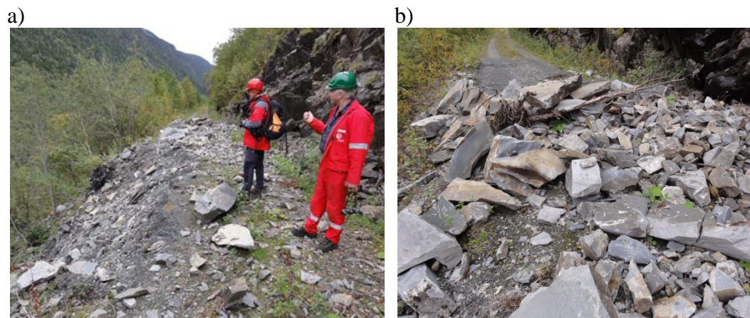
Figur 6: a) Bildene viser utfall mot vei fra samme steinsprang som omtalt over i figur 5. Skredet har gått vis a vis Flåten, se S5 i kart 2. b) Utfallet: Oppknust stein og blokker opp til ca. 3 m 3 ligger i veibanen. Steinspranget har tatt med seg deler av veien.
