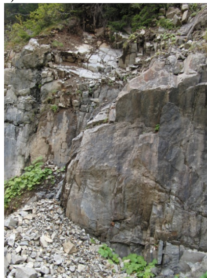
Figur 9: a) Dette utfallet har et større volum, og ligger vis a vis Våer øst. Utfallet består av godt oppknust materiale, samt en del større blokker som har kommet helt ut i veien. b) Utløsningsområdet har en vifteform og ligger like over veibanen. Et bergparti som sannsynligvis var meget oppsprukket har glidd ut.
