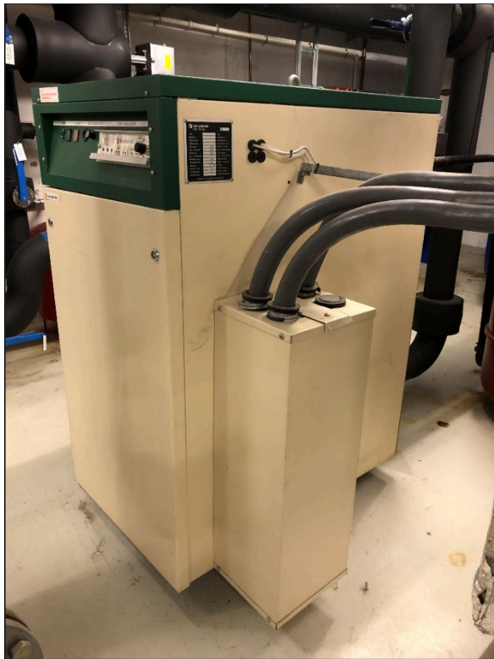
Figur 3.2.1-0: Elektrokjel demonteres. Fysiske mål (LxBxH): 105x70x140 cm. Vannvolum 210 L.
