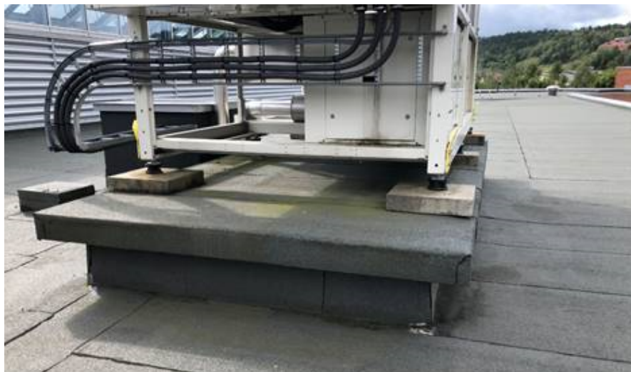
Figur 2.2.0-1: Fundamentet som eksisterende kjølemaskin står på.
