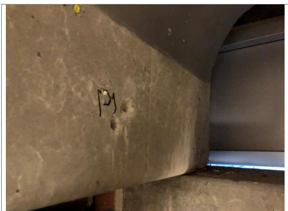
Bilde 1: Betongelement i himling 2. etasje
