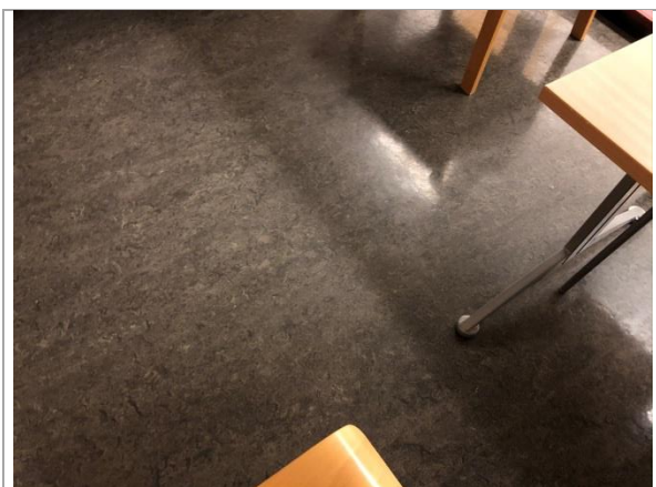
Bilde 2: Gulvbelegg i 3. etasje
