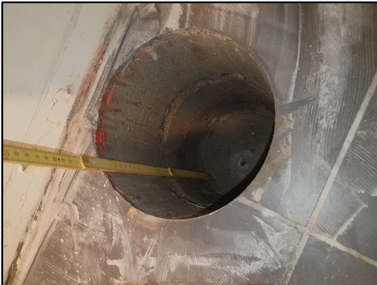
Figur 3 - Gulv korridor Y023
