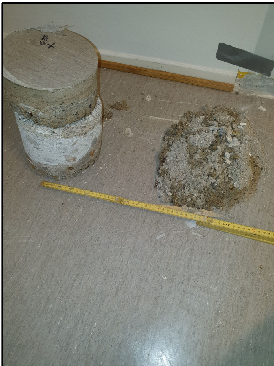
Figur 2 - Gulv korridor Y022
